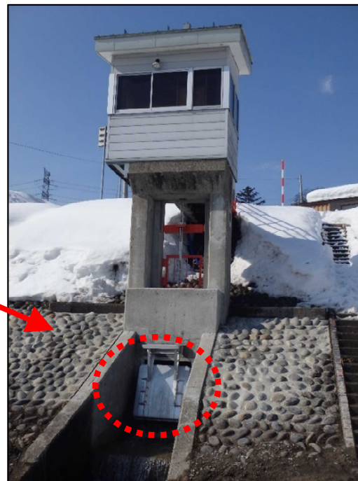
姿樋管フラップゲート化 (全景)
