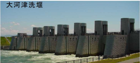
大河津分水路における堰の高さを抑えて景観へ配慮した事例 (図2.2.11)
