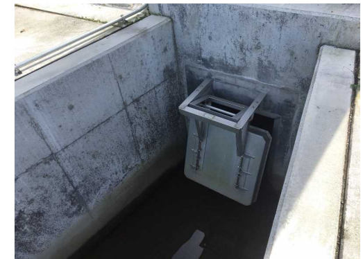
江添川樋管フラップゲート化 (近景)
