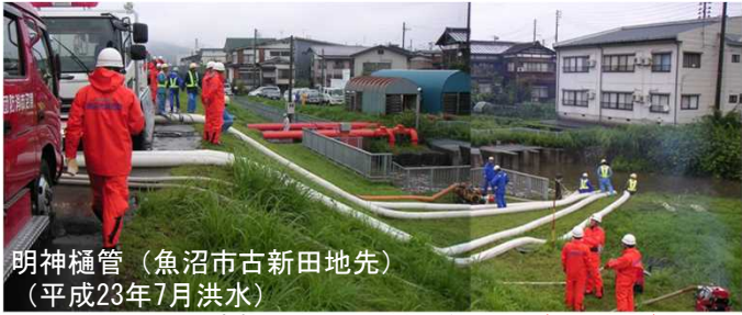
排水ポンプ車による内水排除状況 (図2.2.5)
