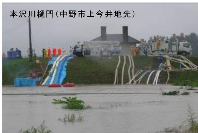
写真 6 内水対策の実施状況(平成 18 年 7 月洪水)
