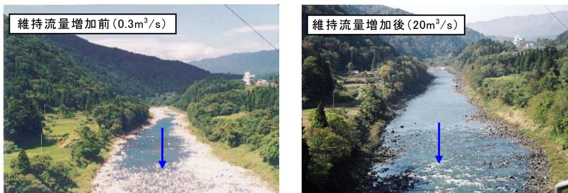
写真 37 西大滝ダムでの維持流量補給の事例
