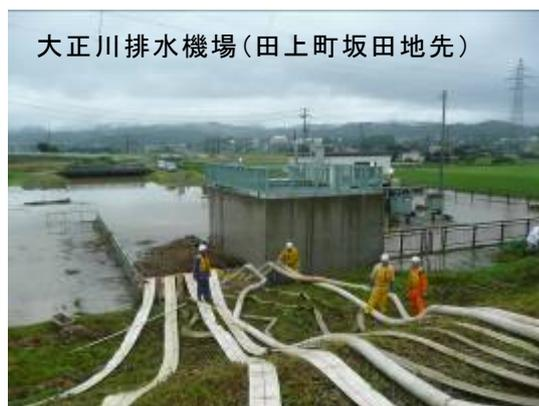
写真 8 内水対策の実施状況(平成 23 年 7 月洪水)
