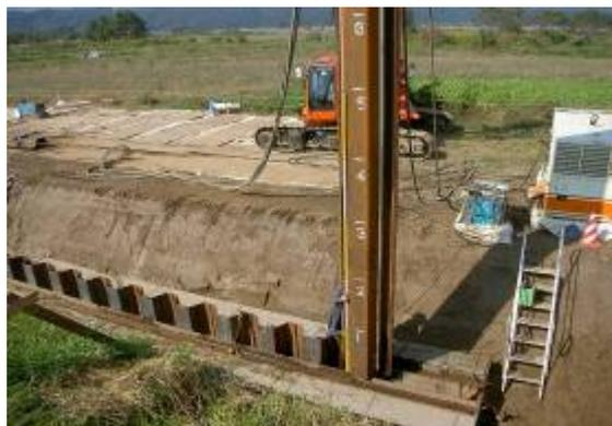
写真 12 漏水対策工事
