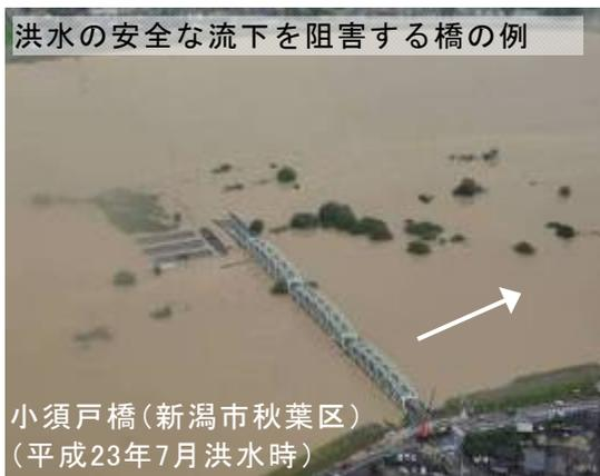
写真 5 改築が必要な横断工作物の例
