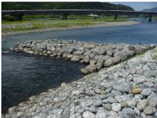
巨石を用いた水制工による淵の創出
