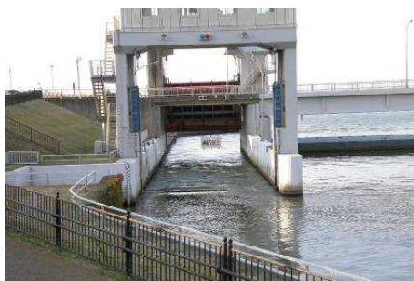
新潟大堰に設置された魚道
