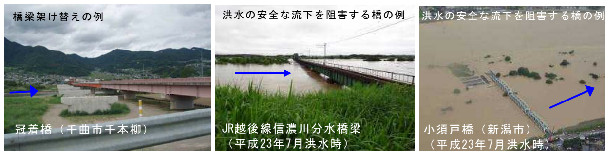
写真 8 改築が必要な横断工作物の例
