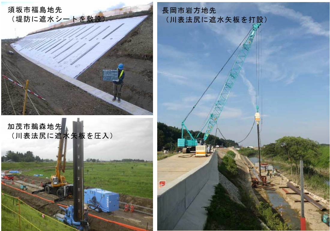
写真 54 浸透対策の実施例
