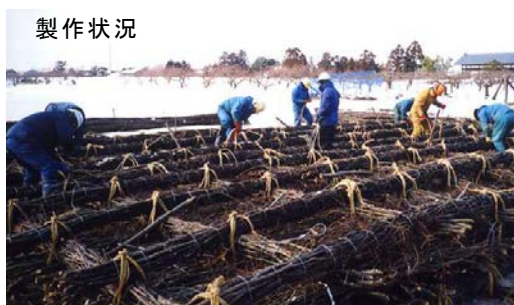
三条市本町地先における粗朶沈床の整備例（平成 21 年）
