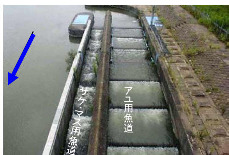
蒲原大堰に設置された魚道
