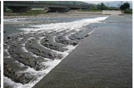
勘左衛門堰（犀川）の魚道
