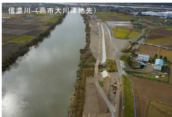
写真 52 堤防整備の実施例
