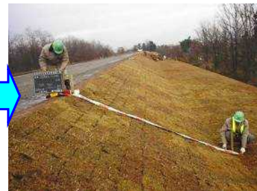
本復旧後の状況
