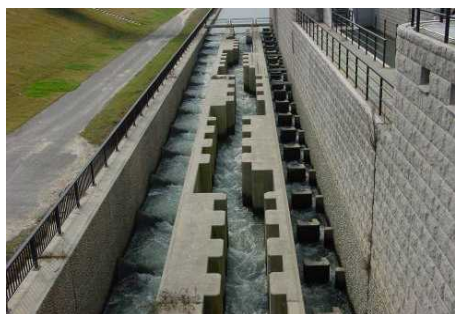
大河津洗堰魚道
