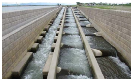
大河津可動堰魚道
