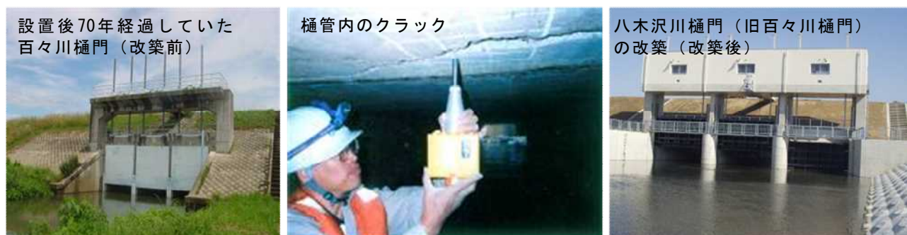
写真 19 八木沢川樋門(千曲川)の改築状況
