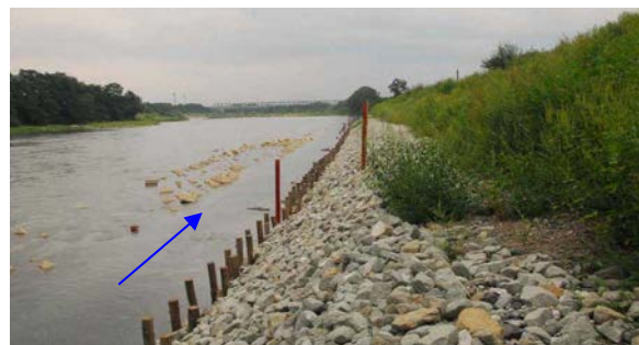
捨石、覆土、木杭による多自然護岸 （犀川 9.0k 付近）
