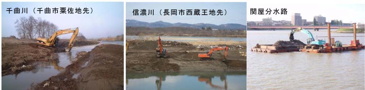
写真 53 河道掘削の実施例
