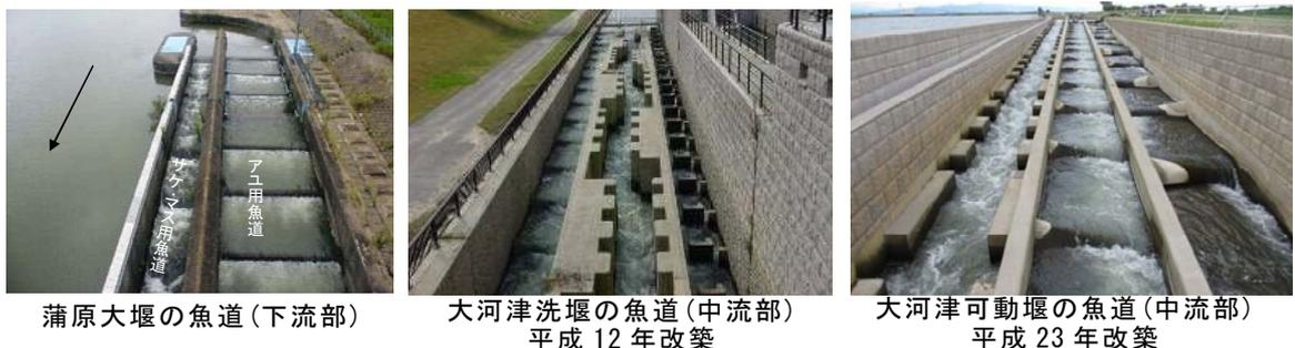
写真 68 魚道の設置事例
