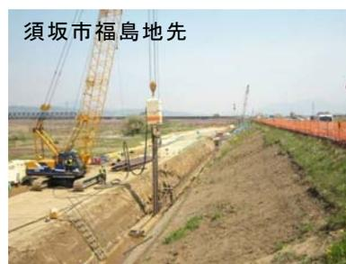
写真 12 漏水対策工事
