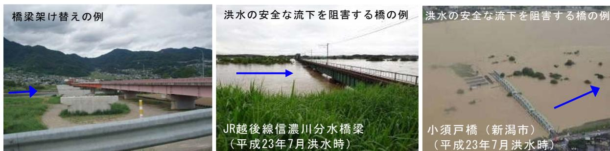
写真 8 改築が必要な横断工作物の例
