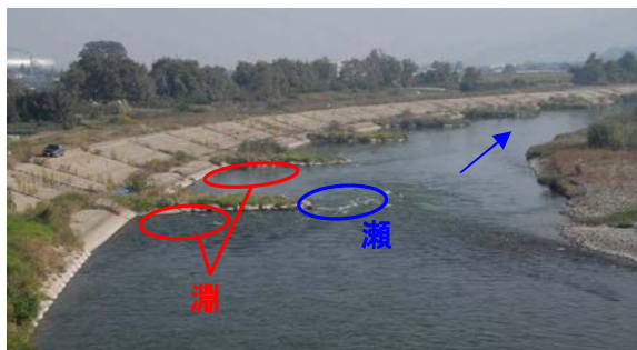
石出しによる不透水制の設置による 瀬・淵の創出（千曲川 70.1k 付近）
