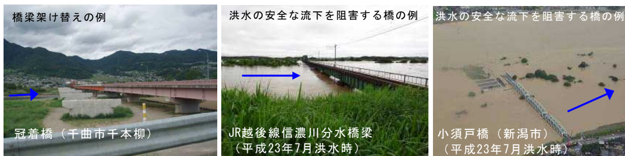
写真 8 改築が必要な横断工作物の例
