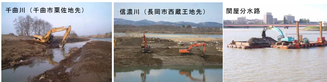
写真 53 河道掘削の実施例
