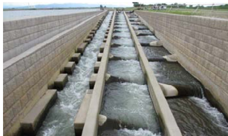
大河津可動堰魚道
