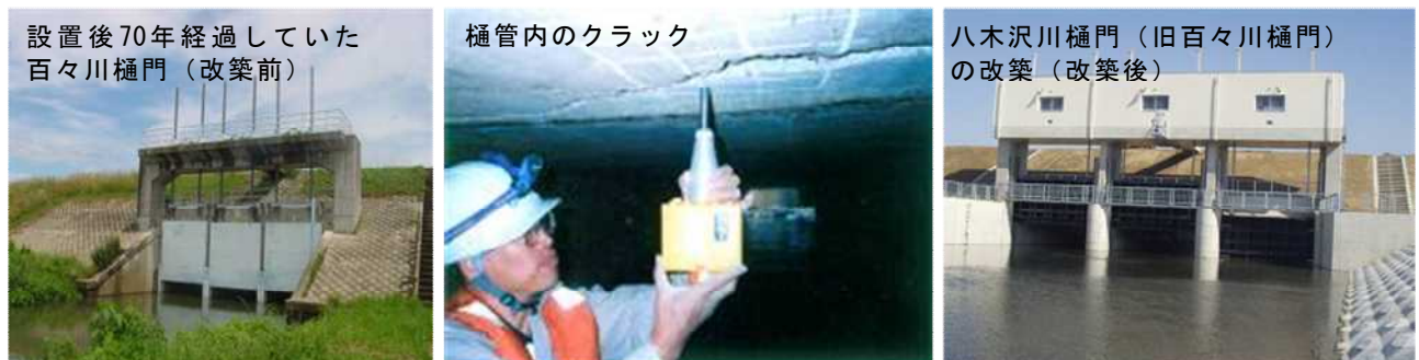
写真 19 八木沢川樋門(千曲川)の改築状況
