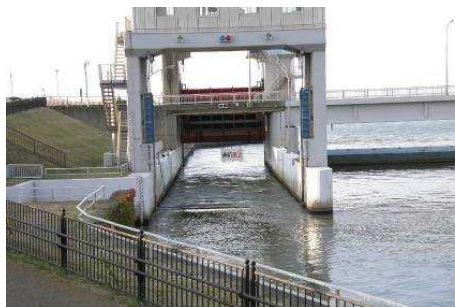
新潟大堰に設置された魚道
