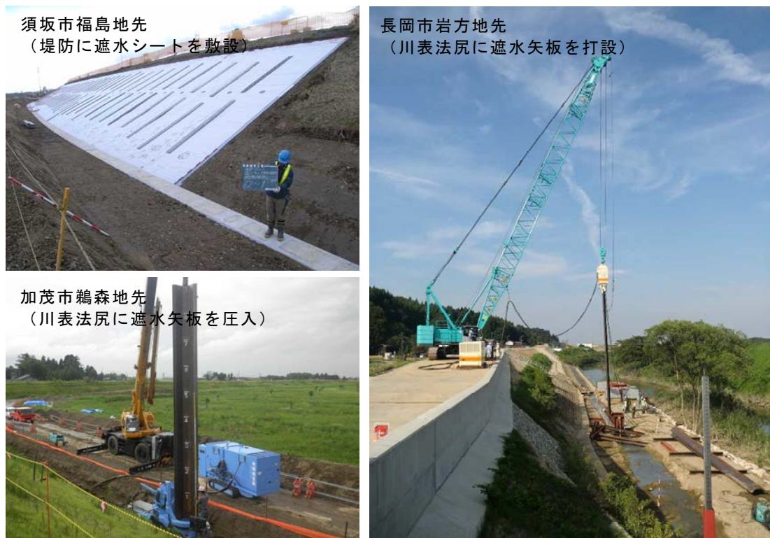
写真 54 浸透対策の実施例
