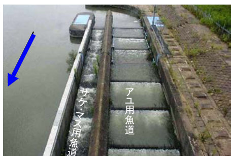
蒲原大堰に設置された魚道
