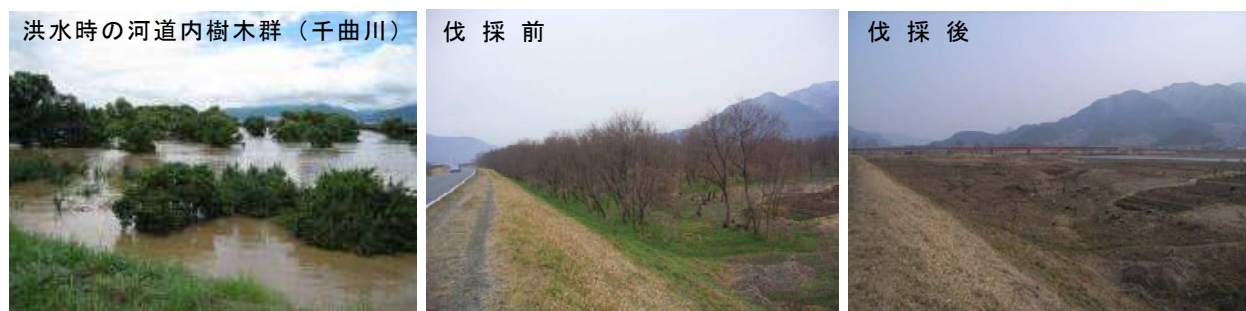
写真 50 樹木伐採の状況(上流部)
