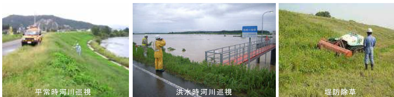
写真 49 河川巡視・堤防除草の状況
