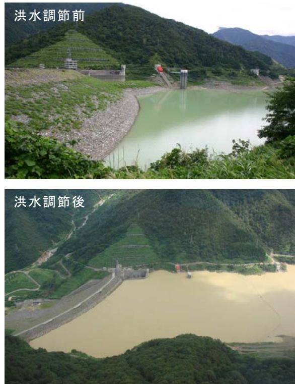
図 14 平成 23 年 7 月洪水時における三国川ダムの洪水調節の様子
