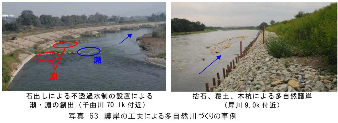
写真 63 護岸の工夫による多自然川づくりの事例
