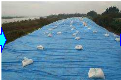
緊急復旧完了 (平成16年10月25日)
