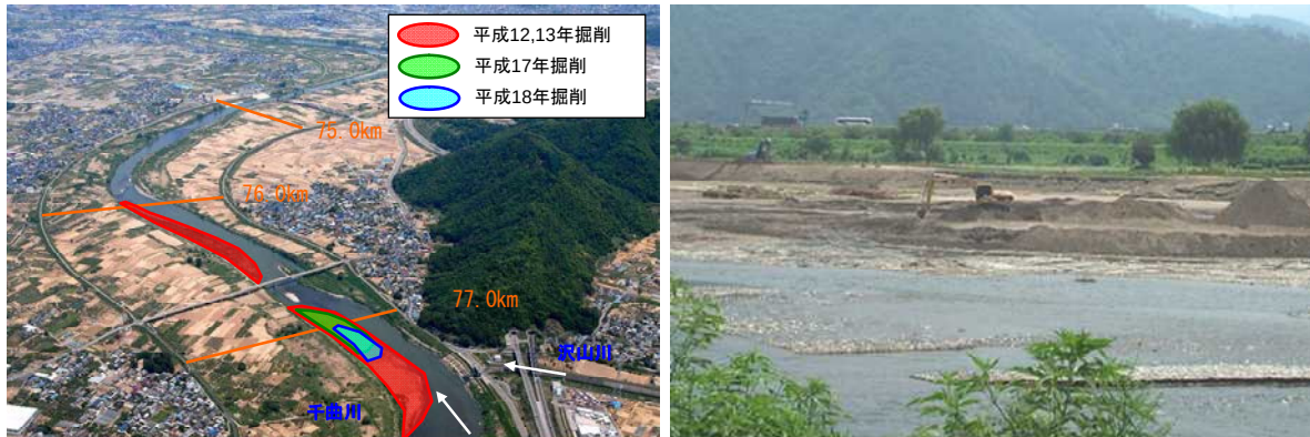
写真 70 維持掘削の実施状況（千曲川沢山川合流点付近）
