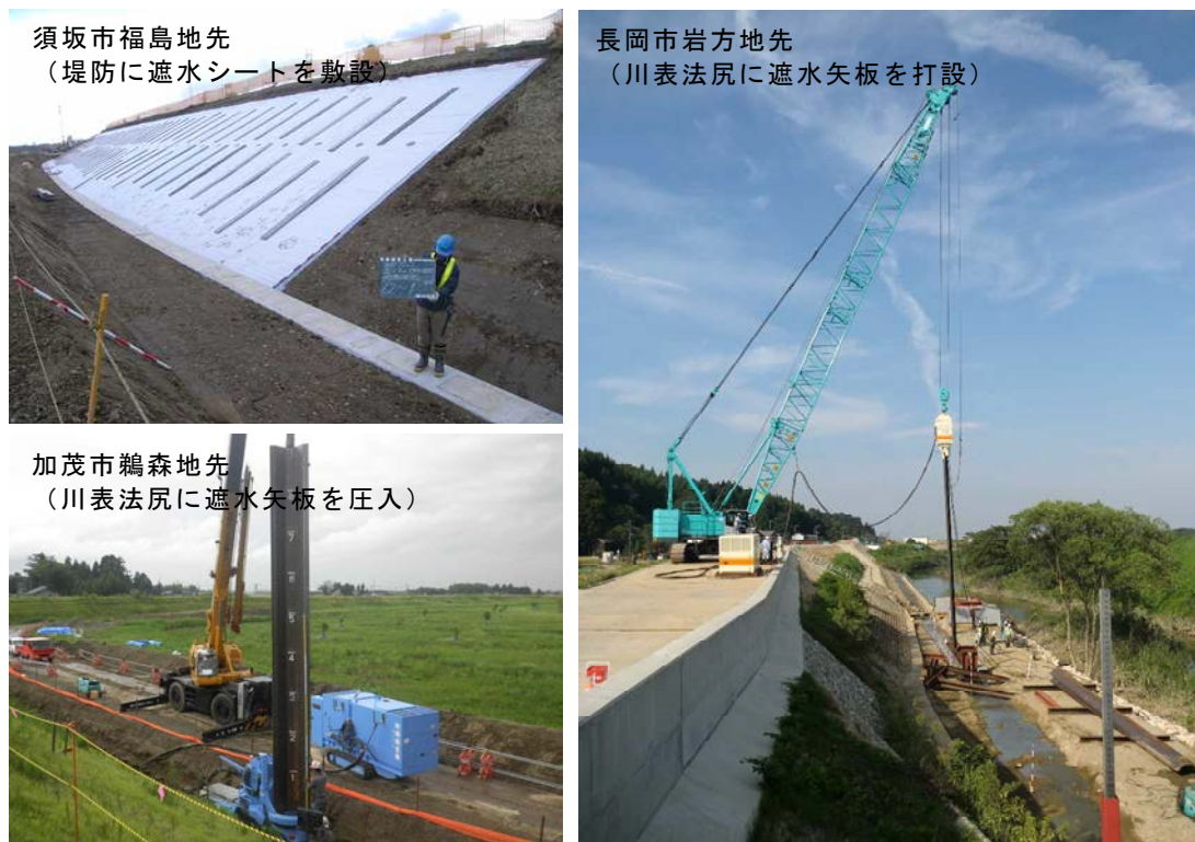
写真 54 浸透対策の実施例
