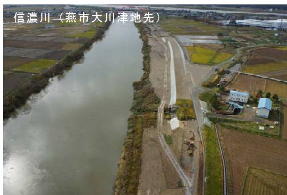
写真 52 堤防整備の実施例
