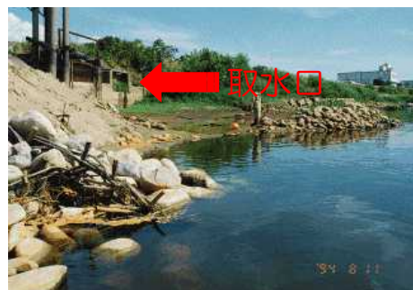
取水口からの取水不能(加茂市)
