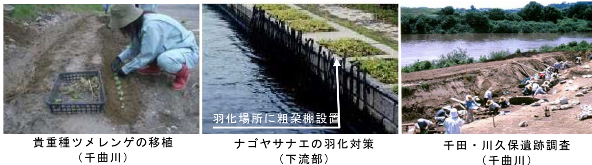
写真 66 工事による環境影響の軽減事例
