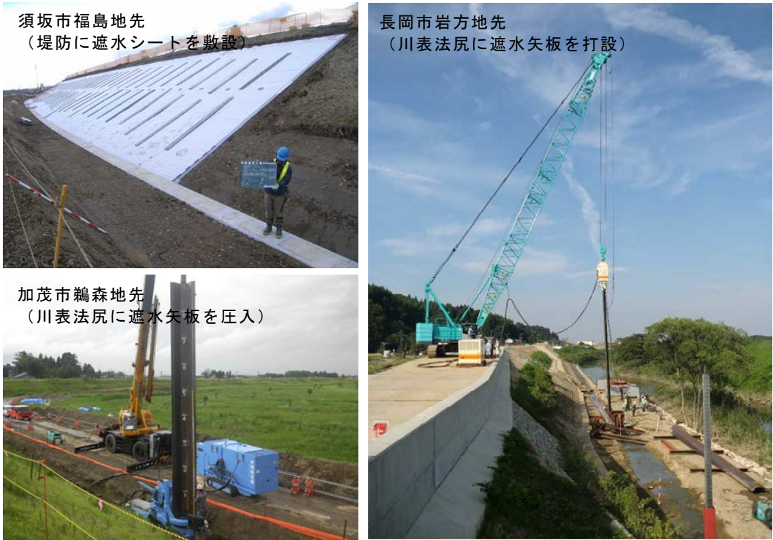
写真 54 浸透対策の実施例
