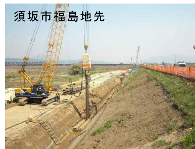
写真 12 漏水対策工事
