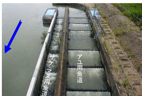
蒲原大堰に設置された魚道
