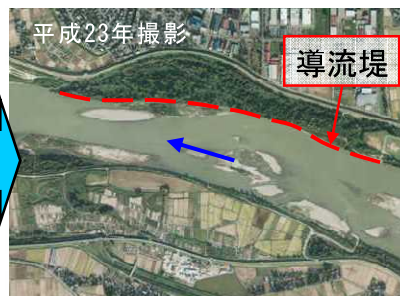
導流堤の施工により低水路が安定
