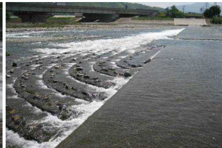
勘左衛門堰（犀川）の魚道
