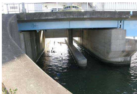
信濃川水門に設置された魚道
