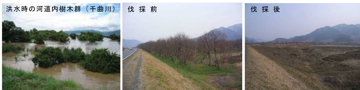
写真 51 樹木伐採の状況（上流部）
