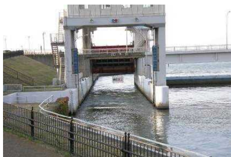
新潟大堰に設置された魚道
