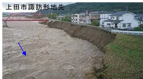
令和元年東日本台風による堤防欠損
