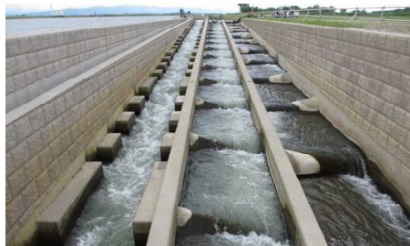
大河津可動堰魚道
