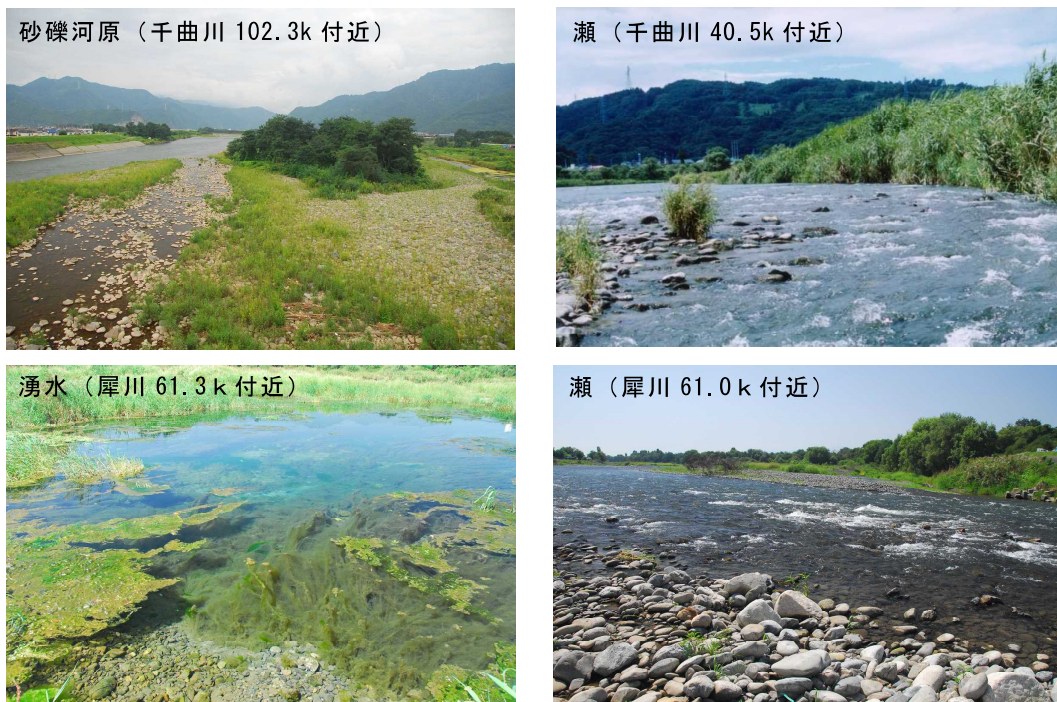
写真 27 上流部の代表的な河川環境の状況
