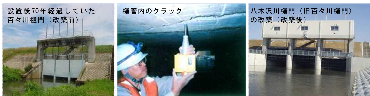
写真 17 八木沢川樋門（千曲川）の改築状況
