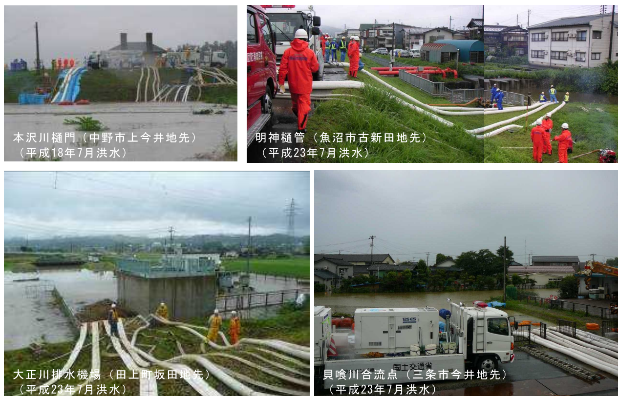
写真 9 内水被害発生と対策の実施状況
