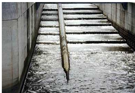
大島頭首工に設置された魚道
