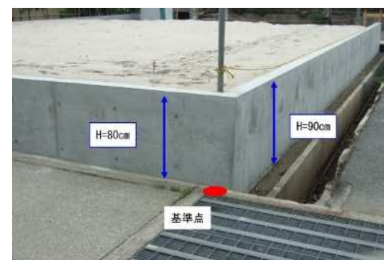
宅地かさ上げ状況
