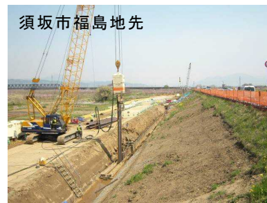
写真 12 漏水対策工事
