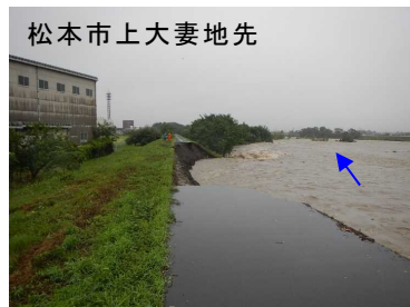
松本市上大妻地先 令和3年8月洪水による堤防欠損
