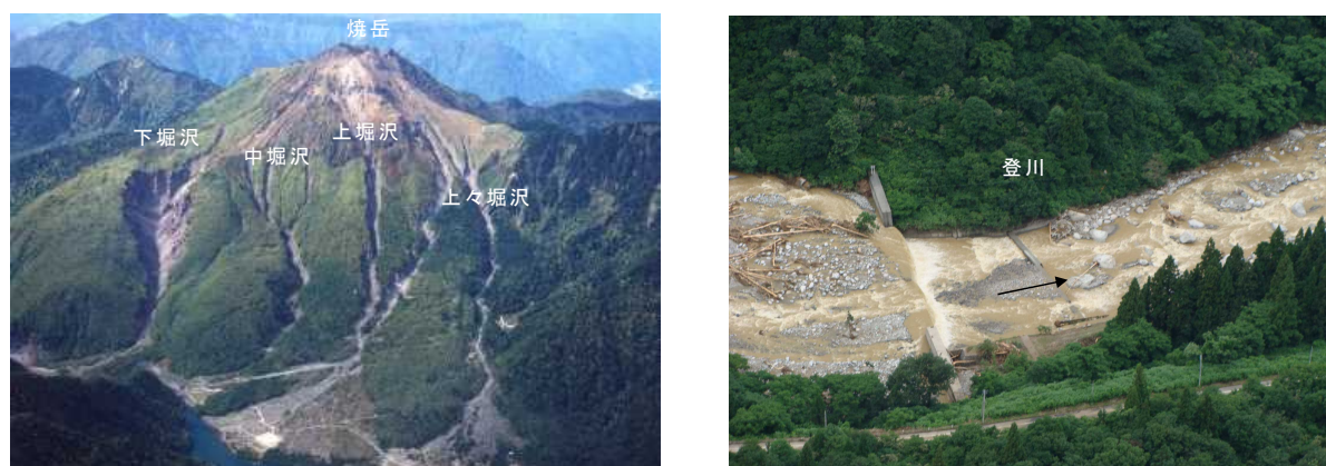
写真 20 梓川、魚野川上流域の荒廃状況、砂防堰堤の堆砂状況
