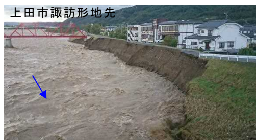
上田市諏訪形地先 令和元年東日本台風による堤防欠損
