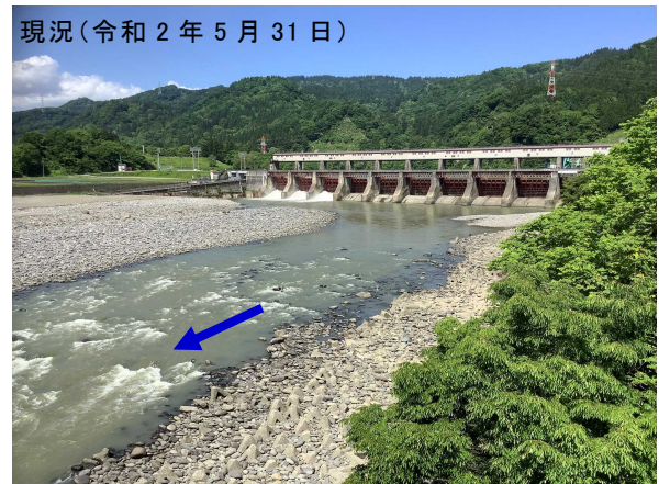
写真 24 宮中取水ダムの放流による減水区間の改善状況
