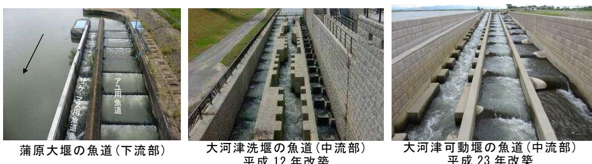
写真 66 魚道の設置事例
