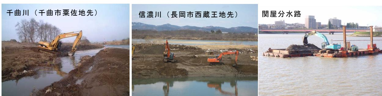
写真 55 河道掘削の実施例
