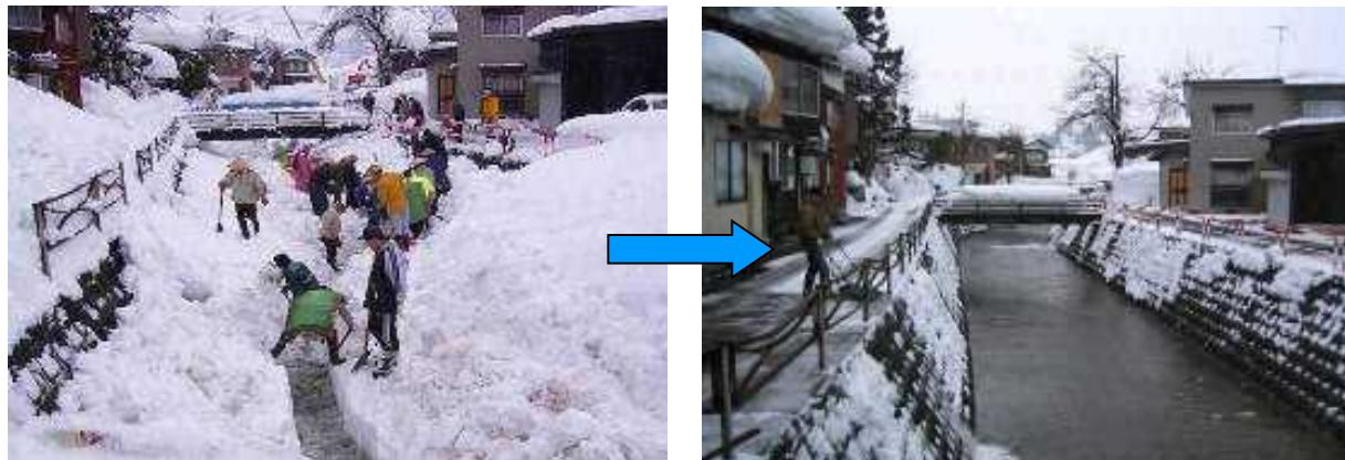
写真 59 与越川の堀之内消流雪用水導入事業による効果(魚沼市)
