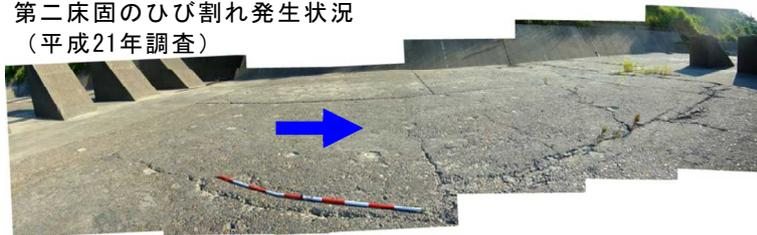
写真 16 大河津分水路 第二床固の老朽化状況
