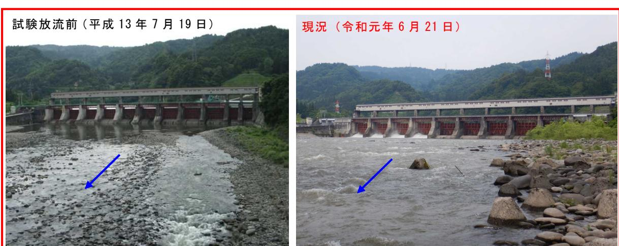
写真 25 宮中取水ダムの放流による減水区間の改善状況
