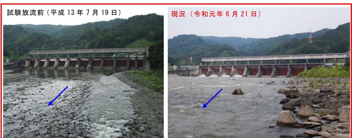
写真 25 宮中取水ダムの放流による減水区間の改善状況
