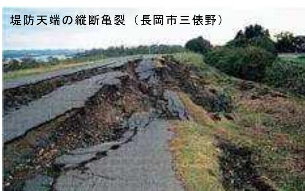
堤防天端の縦断亀裂（長岡市三俵野）
