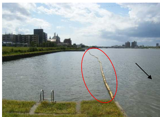
写真 82 不法係留船対策(下流部)
