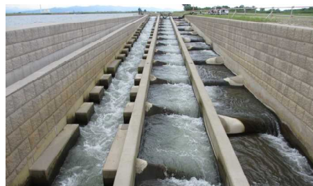
大河津可動堰魚道
