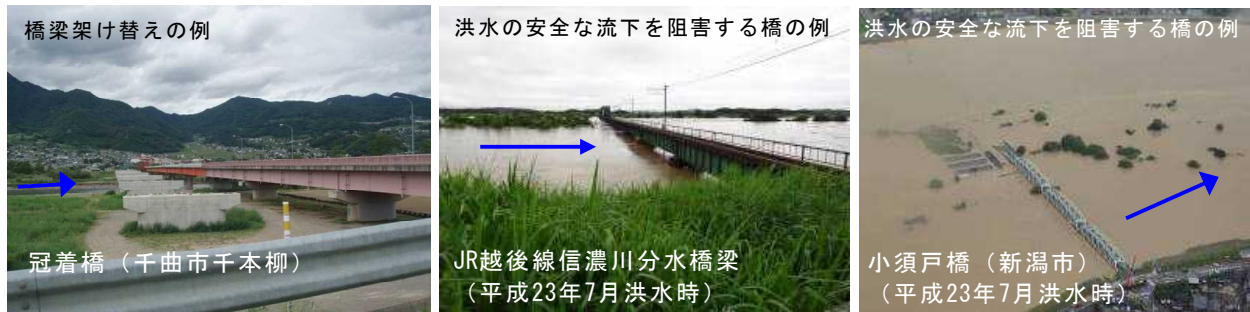
写真 8 改築が必要な横断工作物の例
