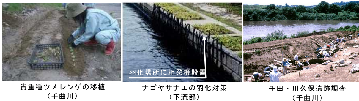
写真 64 工事による環境影響の軽減事例
