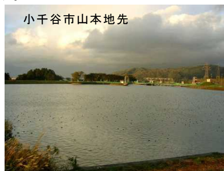
写真 22 山本調整池(JR 東日本、信濃川)
