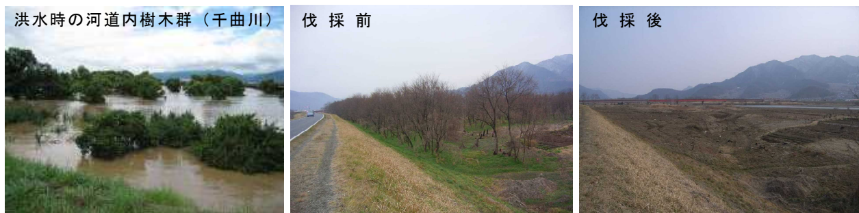
写真 50 樹木伐採の状況(上流部)
