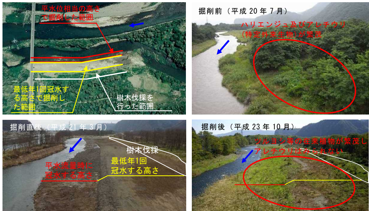
写真 60 多自然川づくりの事例(千曲川・鼠地区での試験掘削)
