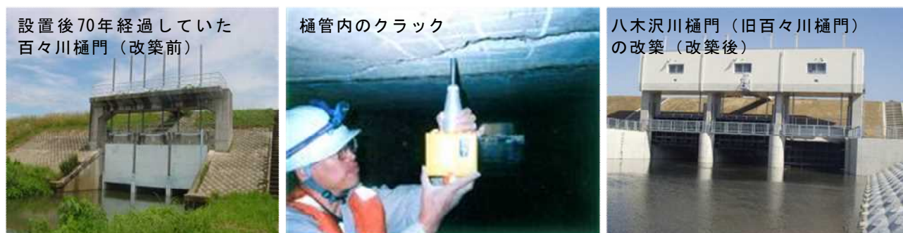
写真 19 八木沢川樋門(千曲川)の改築状況
