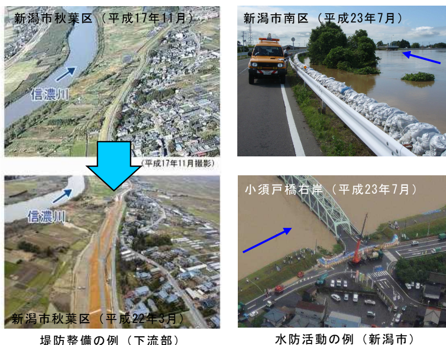
写真 20 平成16年7月洪水後とその後の対策状況(左)及び平成23年7月洪水時の状況
