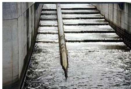
大島頭首工に設置された魚道
