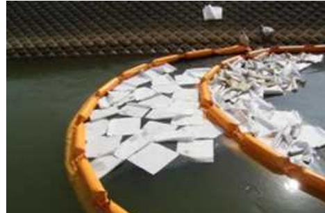
長岡市須川での油除去作業
