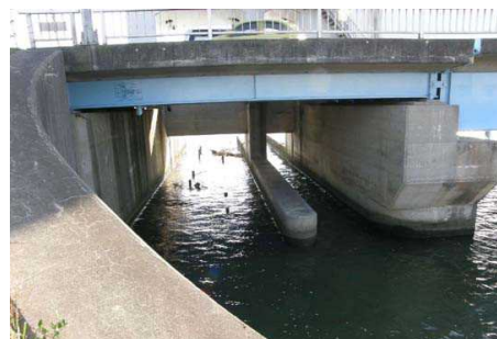
信濃川水門に設置された魚道
