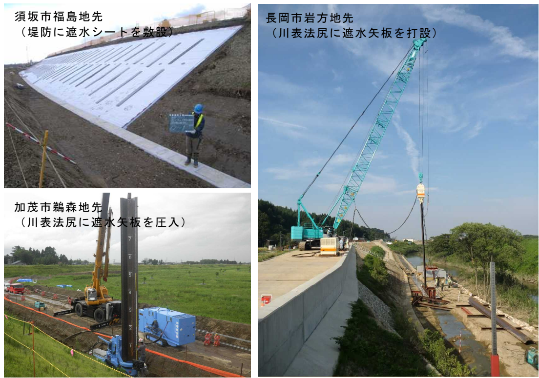
写真 54 浸透対策の実施例
