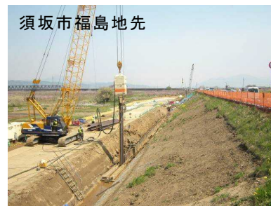
写真 12 漏水対策工事
