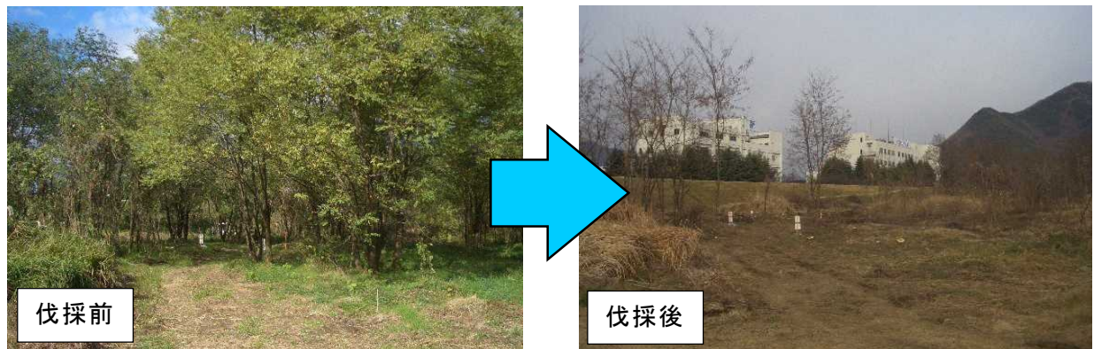
写真 69 樹木管理の事例(千曲川 坂城町上五明地先)
