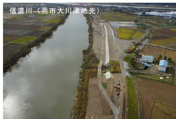
写真 52 堤防整備の実施例
