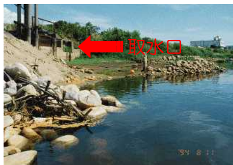
取水口からの取水不能(加茂市)
