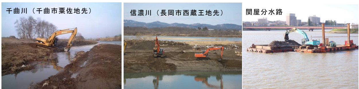
写真 53 河道掘削の実施例
