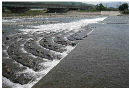
勘左衛門堰（犀川）の魚道
