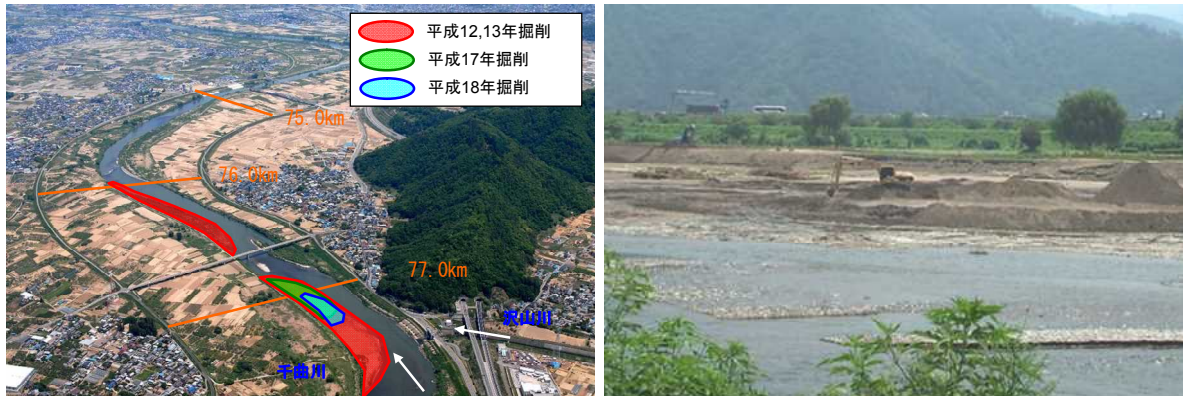
写真 68 維持掘削の実施状況(千曲川沢山川合流点付近)
