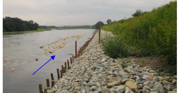
石出しによる不透水制の設置による瀬・淵の創出（千曲川 70.1k 付近）
