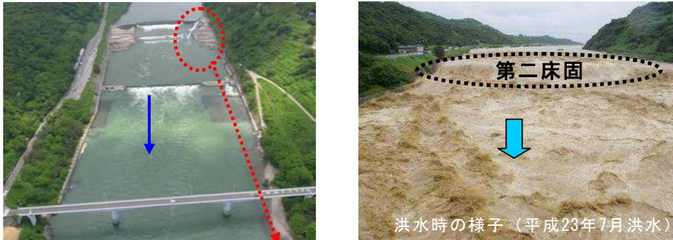
第二床固のひび割れ発生状況
