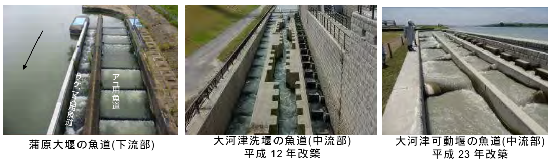
写真 32 魚道の設置事例
