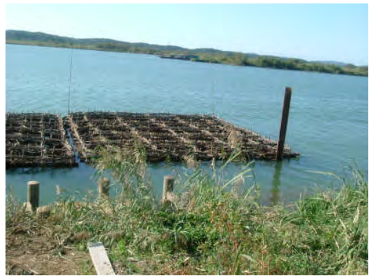
長岡市真代地先(粗朶沈床)
