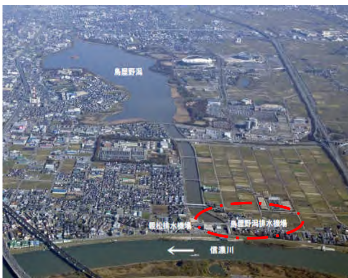
鳥屋野潟排水機場
