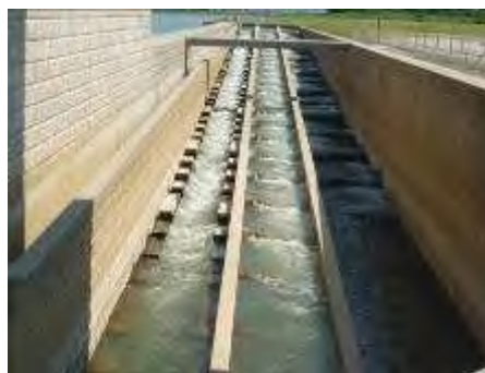
大河津可動堰の新たな左岸魚道
