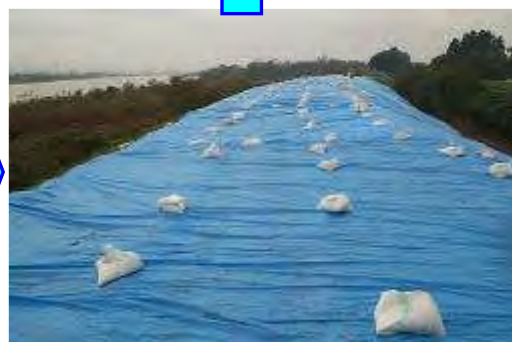
緊急復旧完了 (平成 16 年 10 月 25 日)
