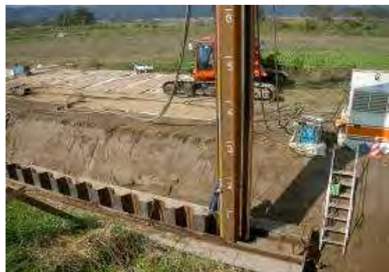
写真 12 漏水対策工事
