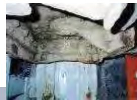
腐食している架台
