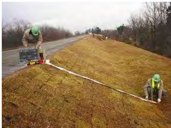
本復旧後の状況
