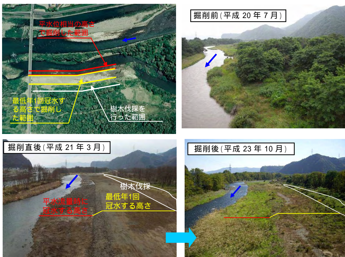
写真 28 多自然川づくりの事例(千曲川・鼠地区での試験掘削)
