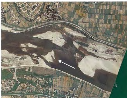
導流堤施工前(昭和 53 年撮影)
