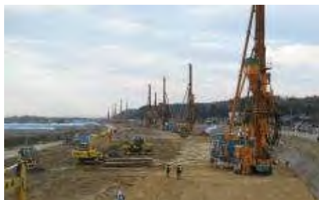
耐震対策の実施状況 (長岡市町軽井)
