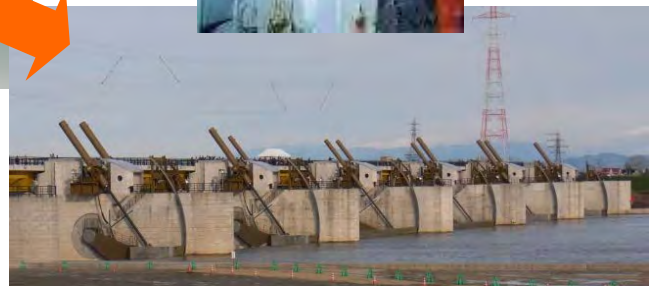
図 22 大河津可動堰の改築状況
