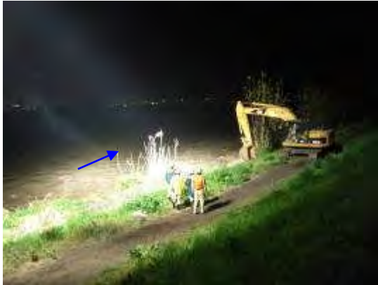
平成 23 年 5 月洪水時の応急対応(長野市網島地先)
