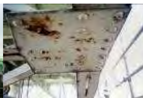
腐食している架台
