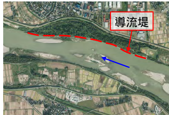
導流堤の施工により低水路が安定(平成 23 年撮影)
