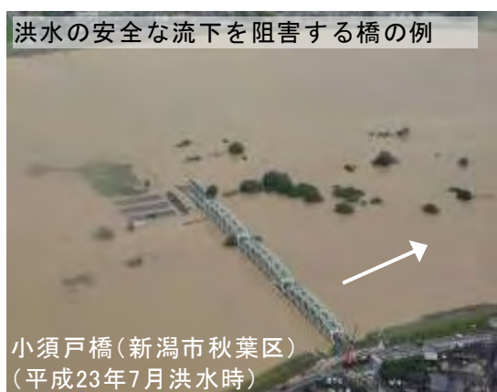
写真 5 改築が必要な横断工作物の例
