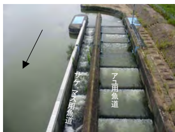
蒲原大堰の魚道(下流部)
