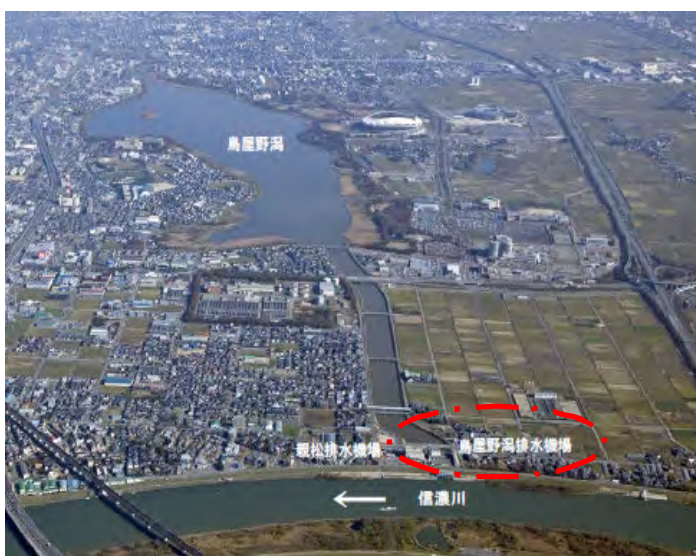
鳥屋野潟排水機場
