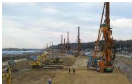
耐震対策の実施状況 (長岡市町軽井)
