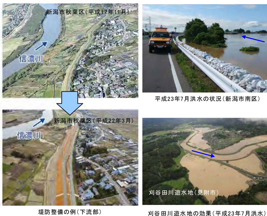
図 23 平成 16 年 7 月洪水後の対策とその後の状況
