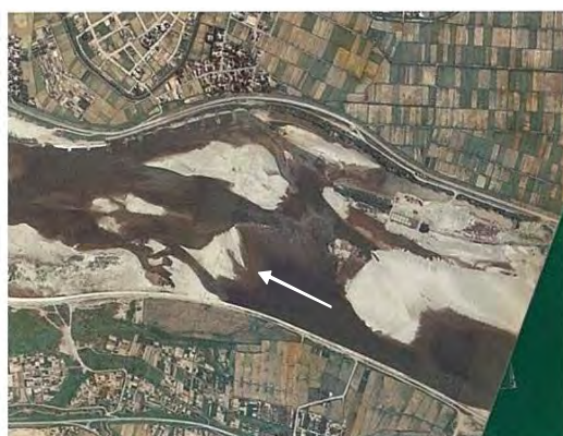
導流堤施工前（昭和 53 年撮影）
