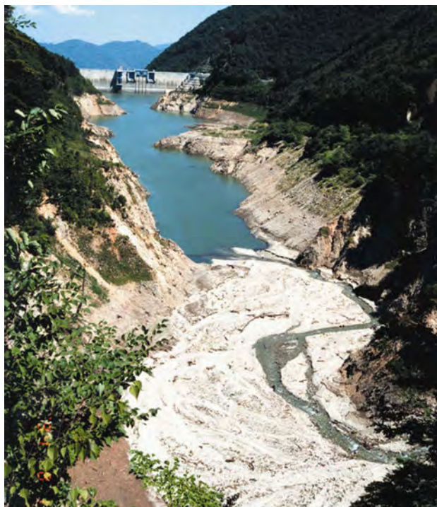
渇水時の大町ダムの状況
