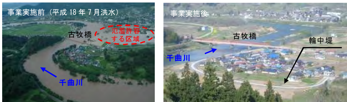
写真 4 土地利用一体型水防災事業で輪中堤を整備した中野市古牧地区(千曲川)
