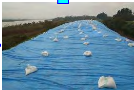
緊急復旧完了 (平成 16 年 10 月 25 日)
