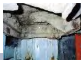
腐食している架台
