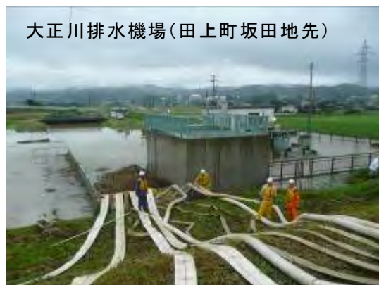
写真 8 内水対策の実施状況(平成 23 年 7 月洪水)
