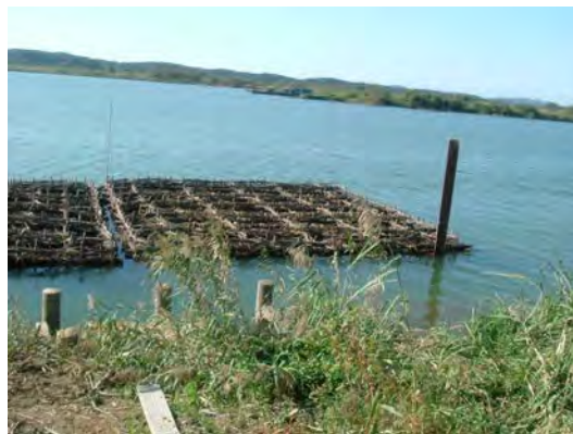
長岡市真代地先(粗朶沈床)
