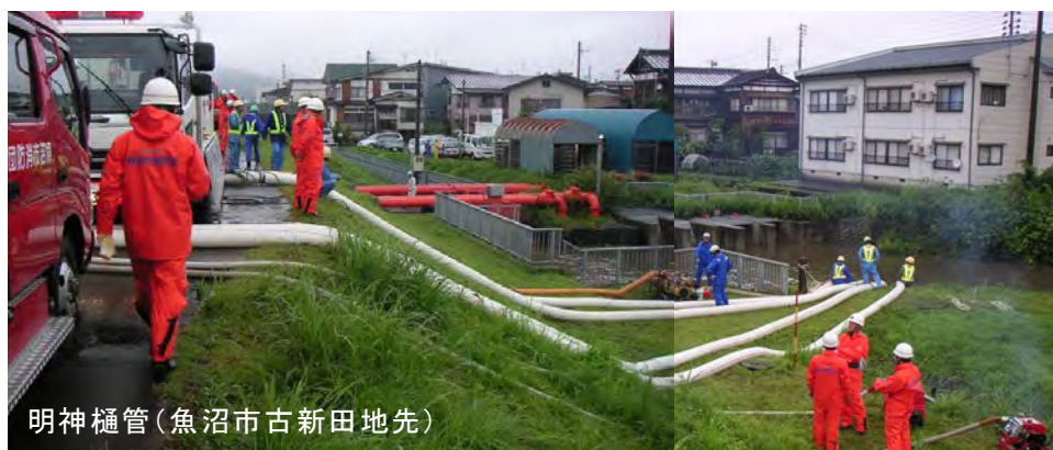
写真 7 内水対策の実施状況(平成 23 年 7 月洪水)
