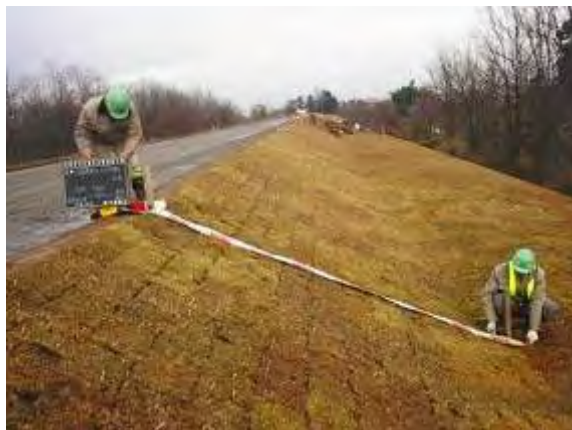
本復旧後の状況
