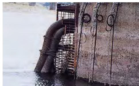
仮設ポンプで取水する 小千谷市水道・工業用水
