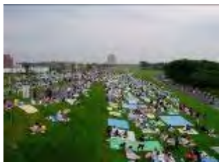
長岡市街地の緩傾斜 堤防：蓮潟地区
