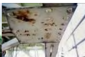
腐食している架台
