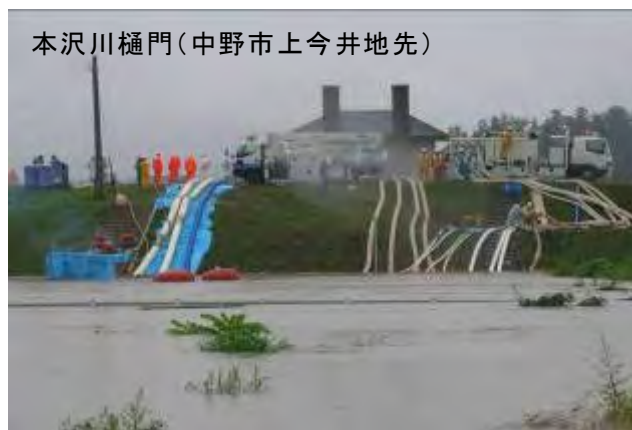
写真 6 内水対策の実施状況(平成 18 年 7 月洪水)
