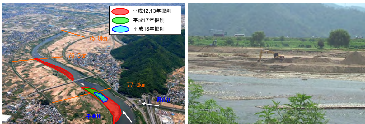
図 41 維持掘削の実施状況(千曲川沢山川合流点付近)
