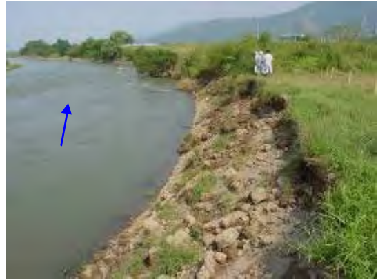
平成 16 年 10 月洪水による河岸の侵食(長野市若穂川田地先)
