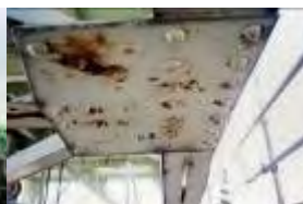
腐食している架台
