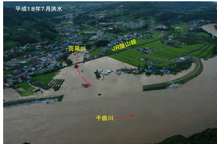
写真 14 支川合流点処理が必要な斑尾川(中野市替佐地区)
