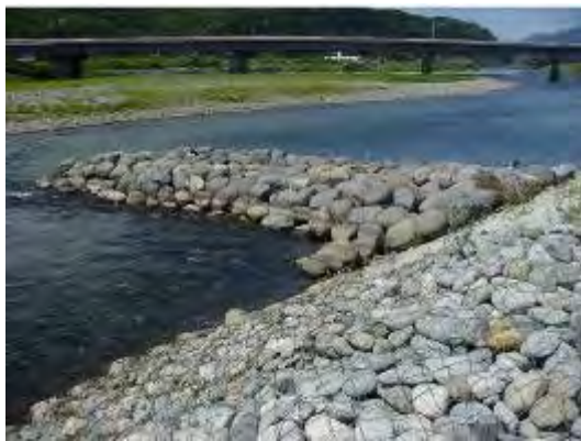
巨石を用いた水制工による淵の創出 (小出地区十日町)
