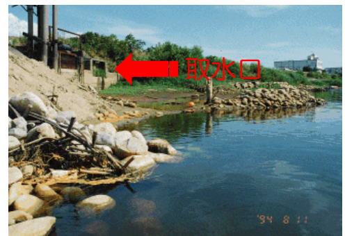
取水口からの取水不能（加茂市）
