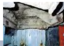
腐食している架台
