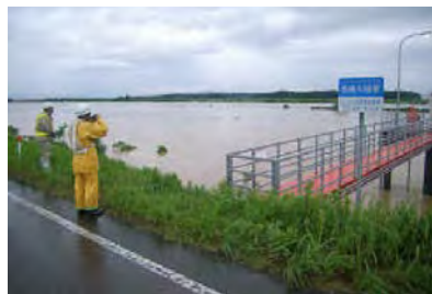
洪水時河川巡視
