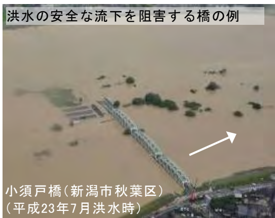
写真 5 改築が必要な横断工作物の例
