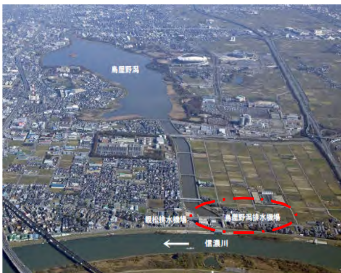
鳥屋野湯排水機場
