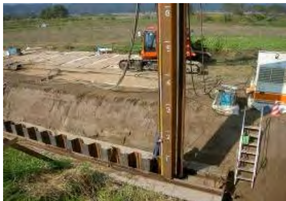
写真 12 漏水対策工事
