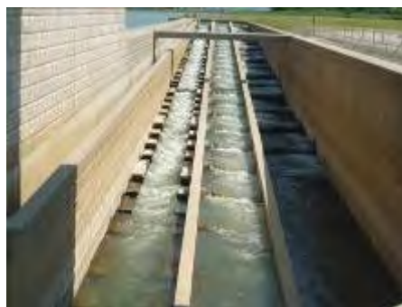
大河津可動堰の新たな左岸魚道
