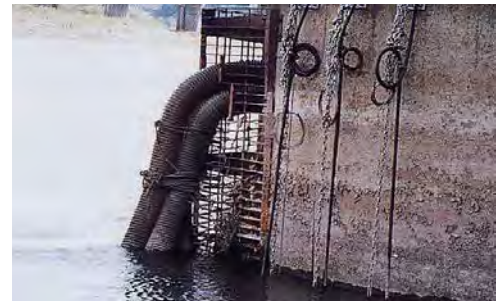
仮設ポンプで取水する 小千谷市水道・工業用水
