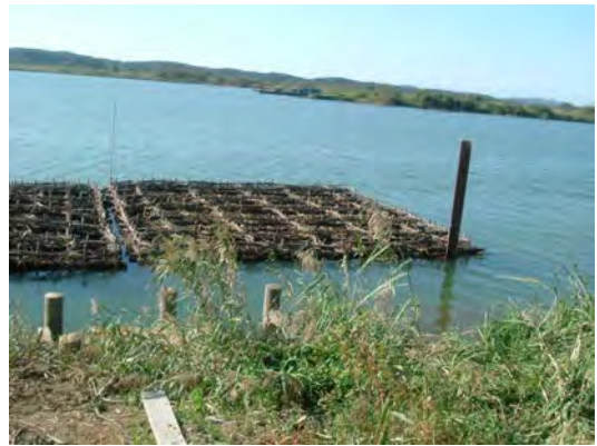
長岡市真代地先(粗朶沈床)
