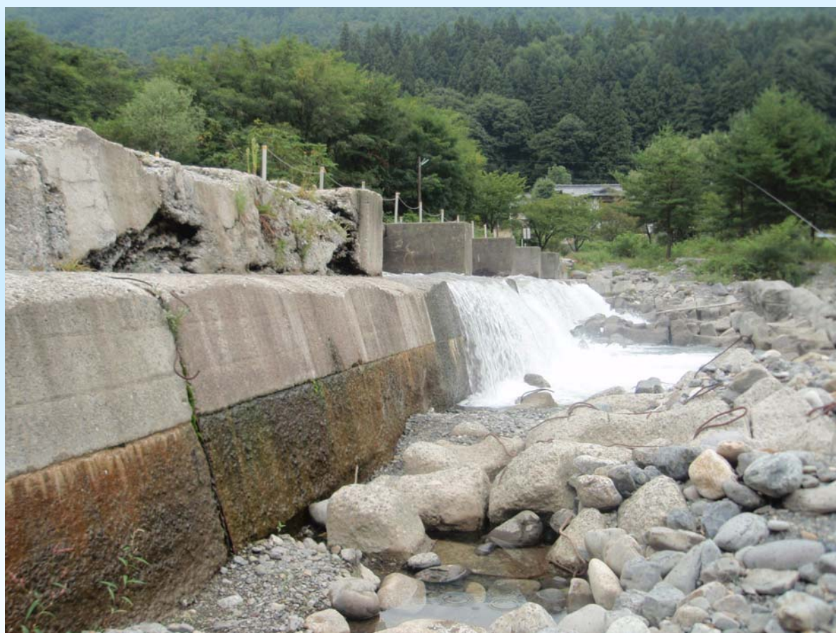
旧赤松頭首工(犀川)の状況
