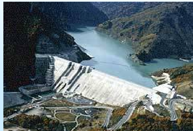
長野市水道の水源の一つである大町ダム
