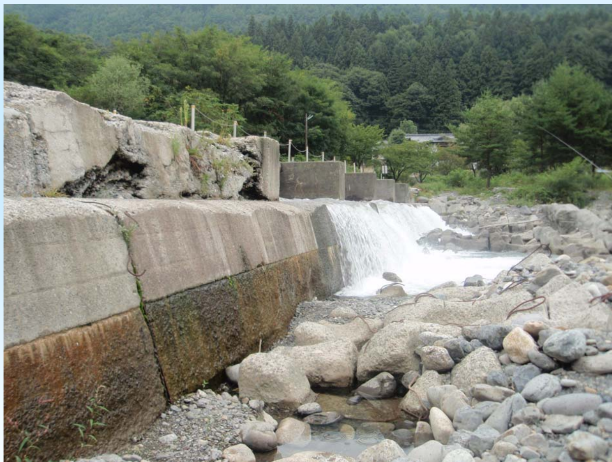
旧赤松頭首工(犀川)の状況
