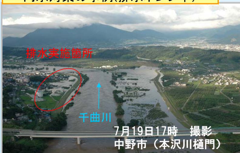
内水対策の事例(排水ポンプ車)
