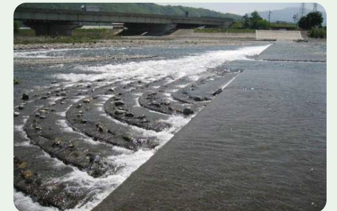
▲勘左衛門堰（犀川）の魚道
