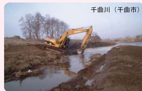
▲河道掘削の実施例
