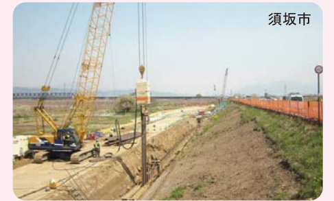
▲漏水対策の実施例
