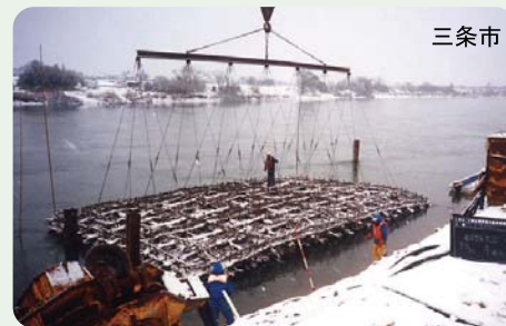
▲粗朶沈床の整備例
