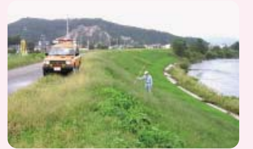
▲河川巡視の状況
