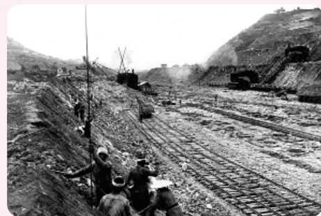
▲大河津分水路開削工事
