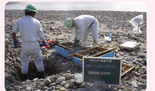
▲河川の調査実施状況（河床材料調査）
