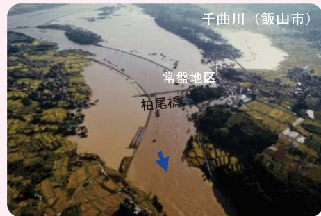
▲千曲川堤防の破堤（昭和58年9月）
