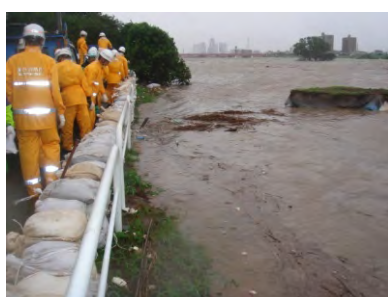
越水に対応するための積土のう工
