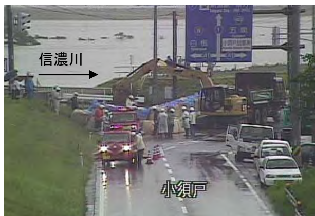
小須戸橋右岸の水防活動 撮影日: 7/30
