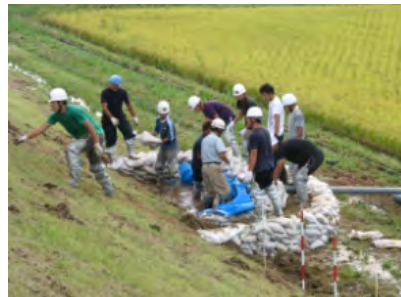
漏水に対応するための月の輪工
