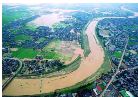
五十嵐川の破堤箇所 三条市
