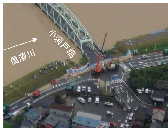
小須戸橋右岸の水防活動 撮影日: 7/30
