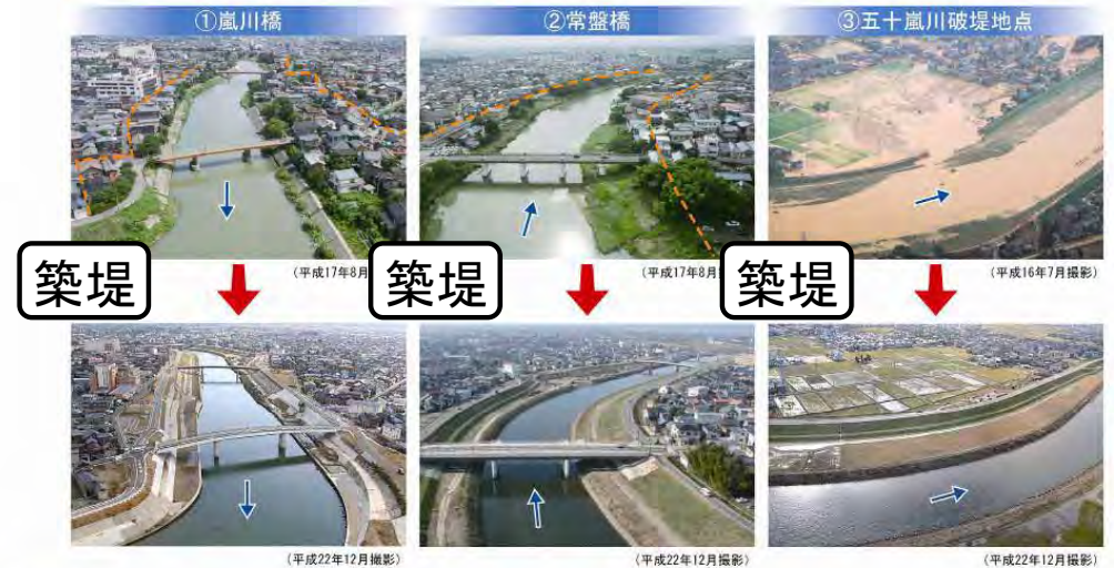
整備前・整備後 写真
