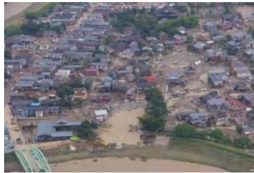
刈谷田川の破堤箇所 長岡市(旧中之島町)
