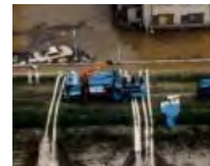
排水ポンプ車による排水
