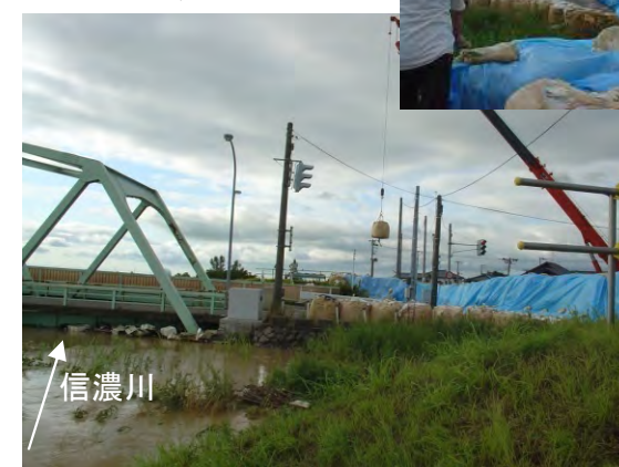
河川水位が上昇したため補強対策を実施 撮影日: 7/30
