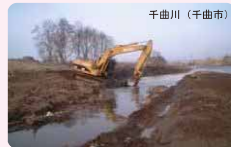
▲河道掘削の実施例
