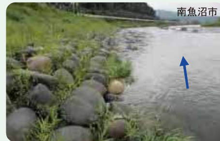
▲多自然川づくりの事例
