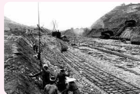
▲大河津分水路開削工事
