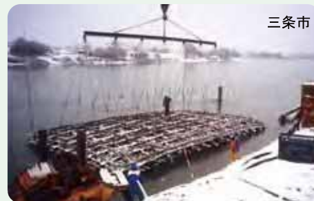
▲粗朶沈床の整備例
