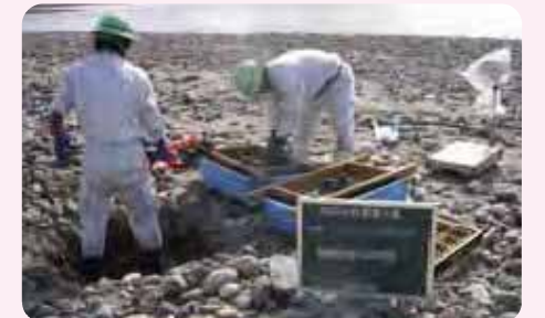
▲河川の調査実施状況(河床材料調査)
