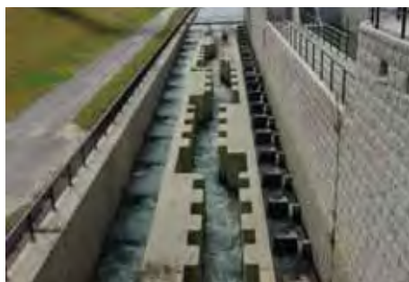
大河津洗堰魚道
