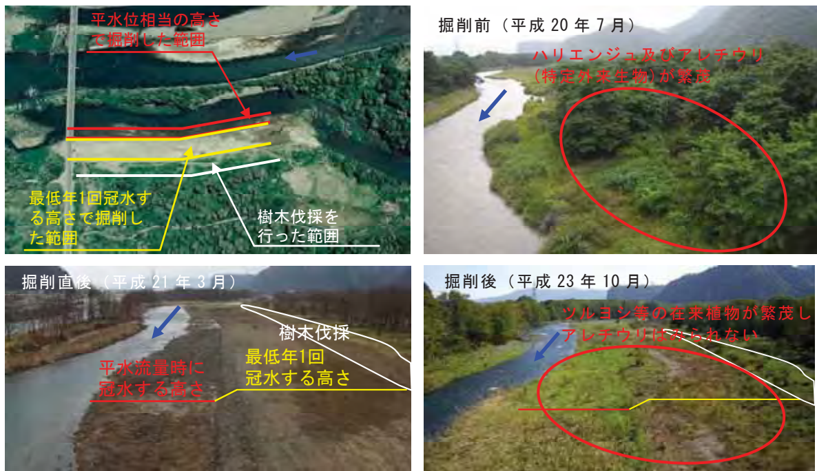
写真 63 多自然川づくりの事例(千曲川・鼠地区での試験掘削)
