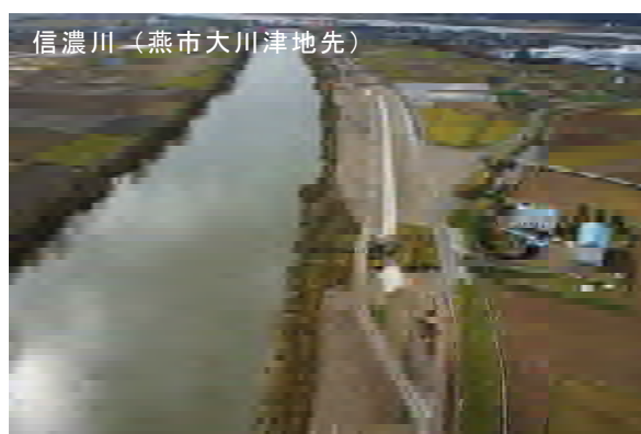
写真 52 堤防整備の実施例
