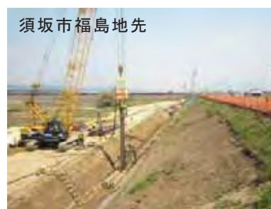
写真 12 漏水対策工事
