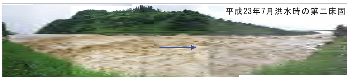
写真 4 大河津分水路全体図と洪水時の様子
