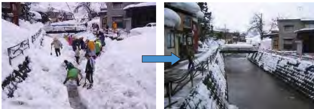
写真 61 与越川の堀之内消流雪用水導入事業による効果(魚沼市)
