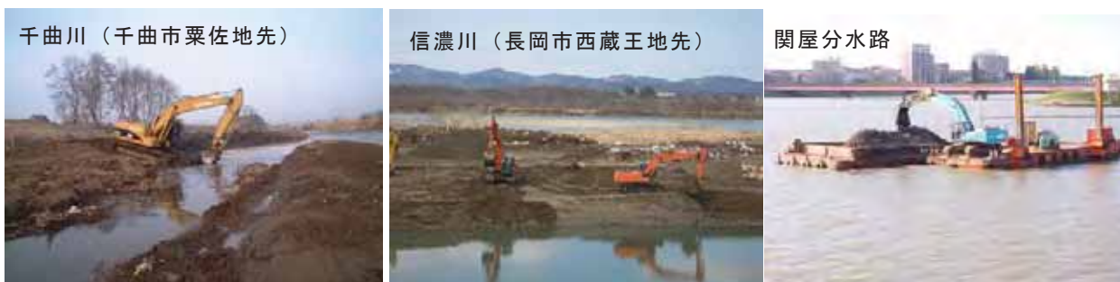
写真 53 河道掘削の実施例
