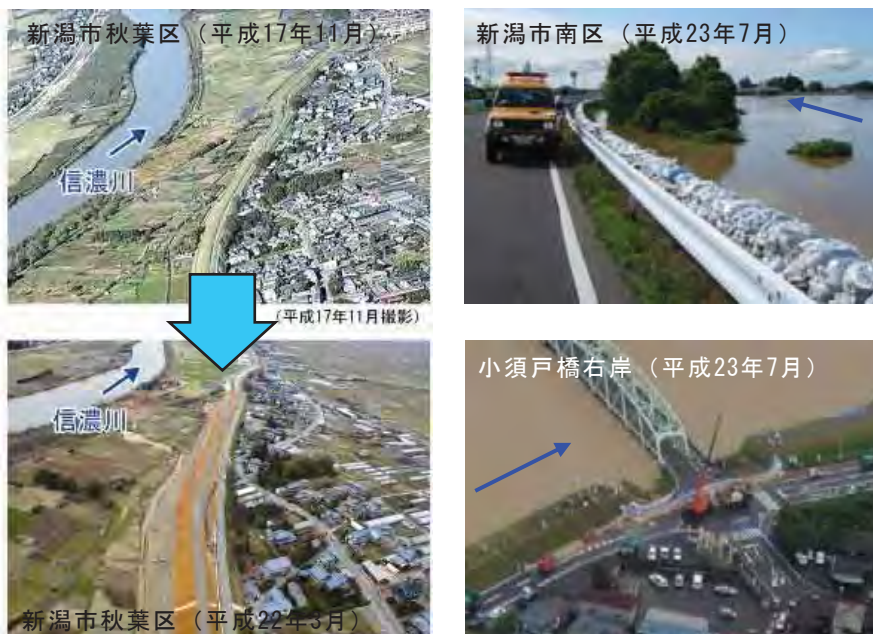
堤防整備の例（下流部）
