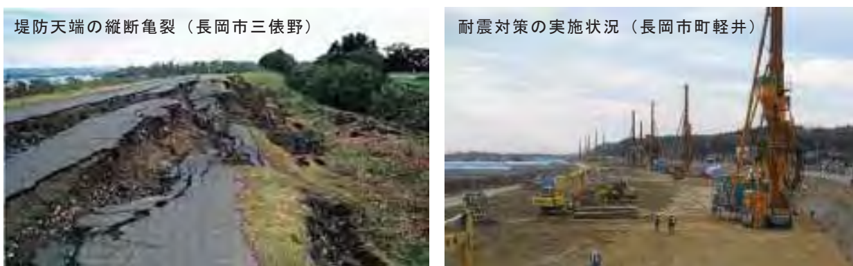
写真 10 新潟県中越地震(左)及び新潟県中越沖地震(右)による堤防の被災状況
