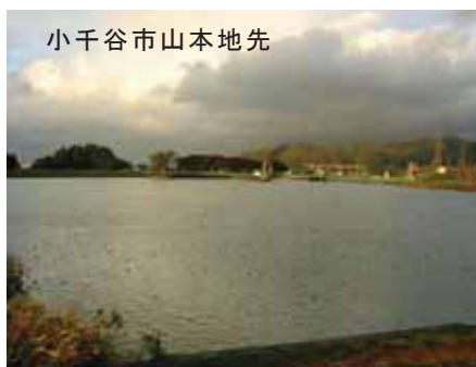
写真 22 山本調整池(JR 東日本、信濃川)
