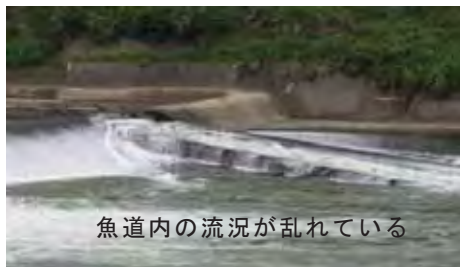
第二床固魚道
