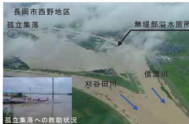
写真 3 平成23年7月洪水における浸水被害の状況
