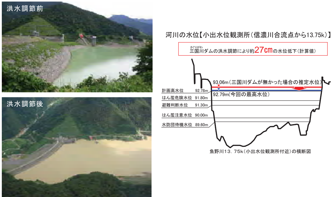
図14 平成23年7月洪水時における三国川ダムの洪水調節の様子
