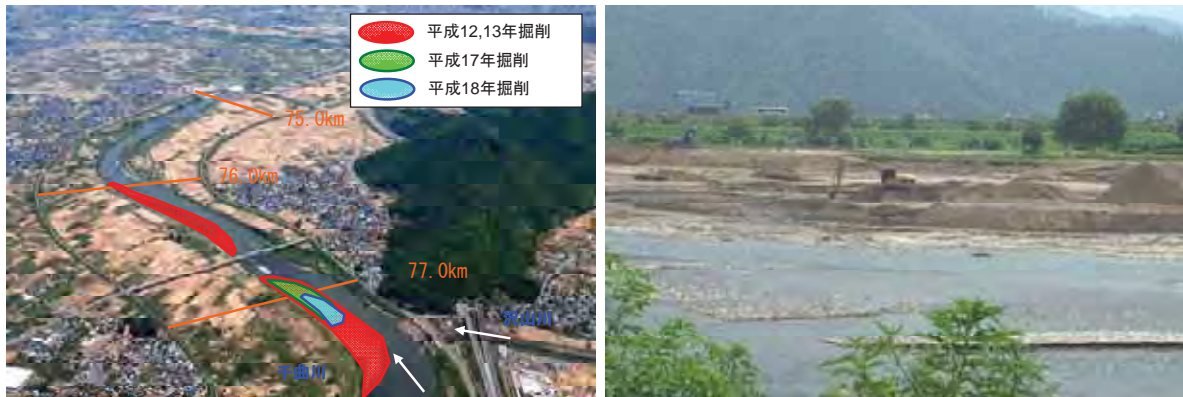
写真 71 維持掘削の実施状況(千曲川沢山川合流点付近)
