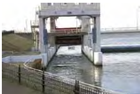
新潟大堰に設置された魚道
