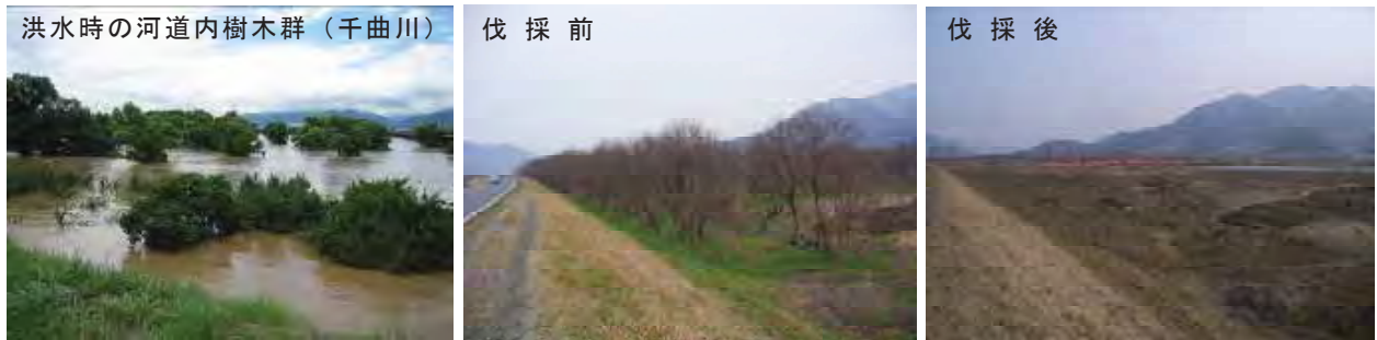
写真 50 樹木伐採の状況(上流部)
