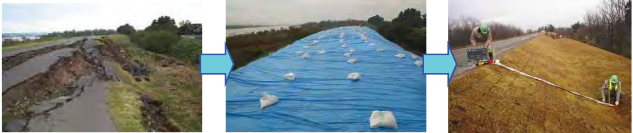
大規模崩壊(長岡市三俵野地先) (平成16年10月24日)
