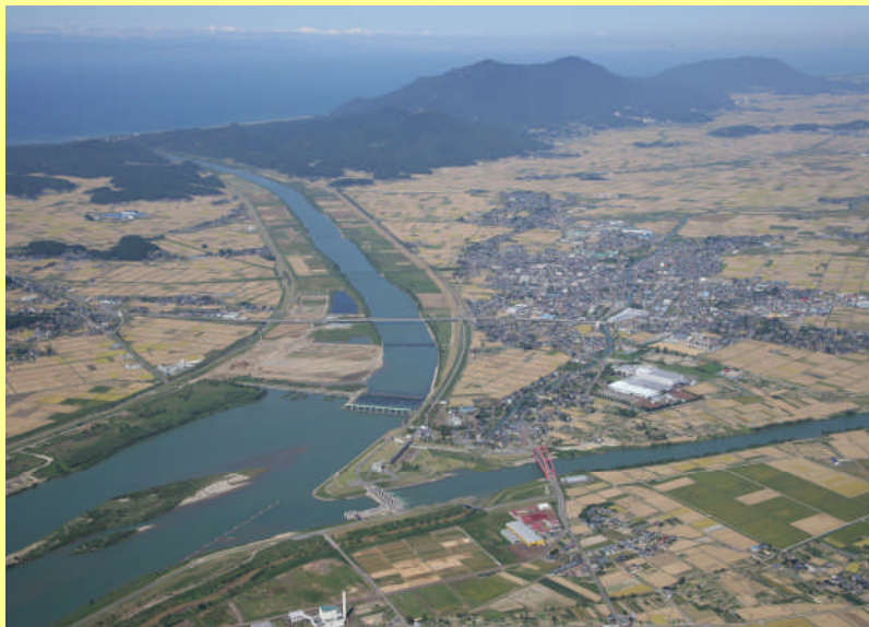
大河津分水路付近
