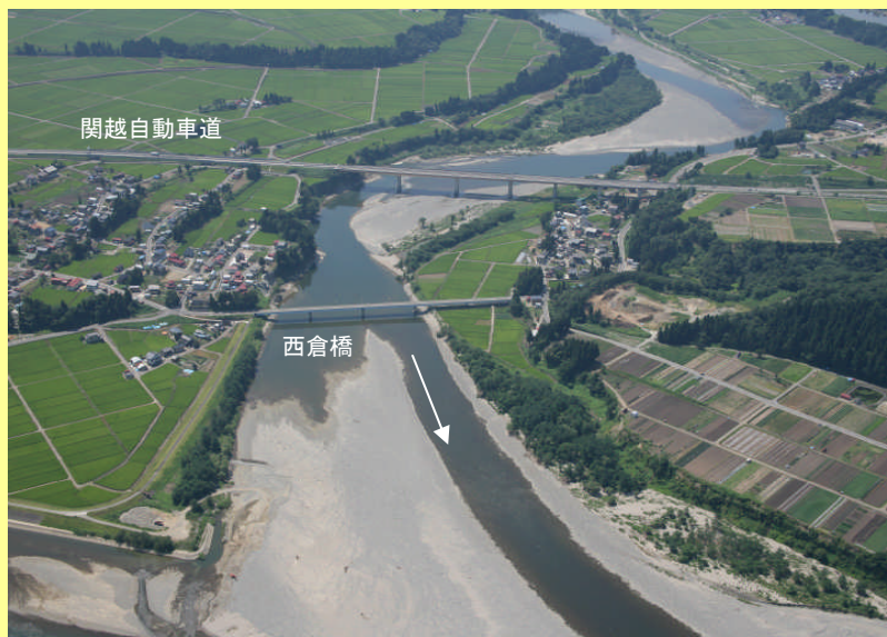
関越自動車道橋梁付近
