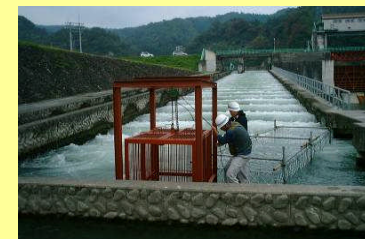
宮中取水ダム魚道
