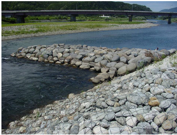
巨石を用いた水制工
