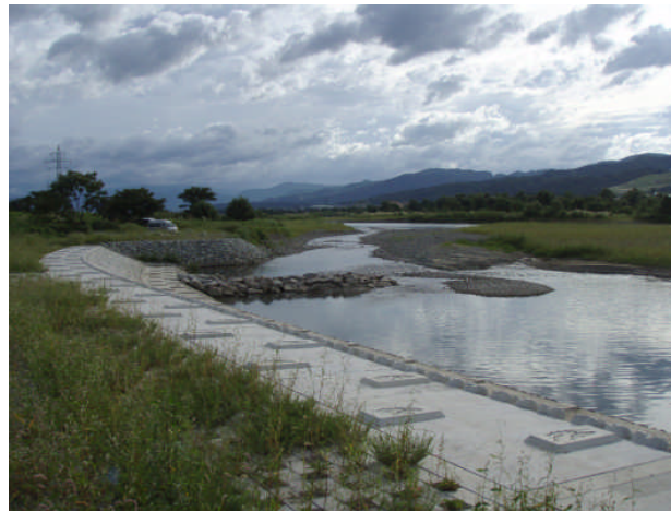
巨石を用いた水制工
