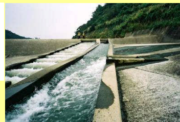
第二床固魚道
