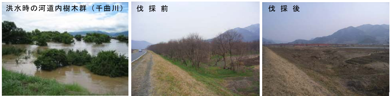
写真 50 樹木伐採の状況(上流部)
