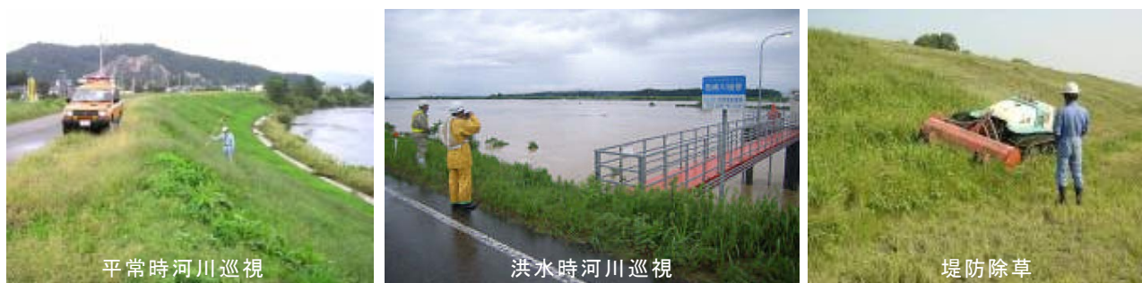
写真 49 河川巡視・堤防除草の状況
