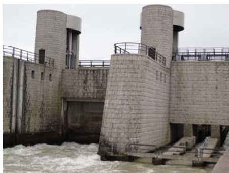
写真 68 大河津分水路における堰の高さを抑えて景観へ配慮した事例
