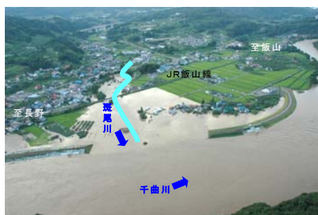
写真15 支川合流点処理が必要な斑尾川(中野市替佐地区)
