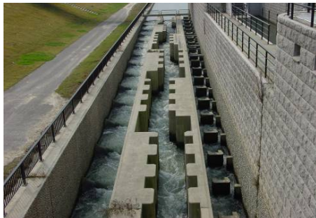
大河津洗堰魚道
