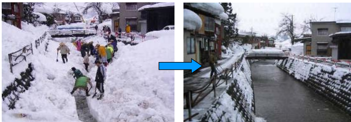
写真 60 与越川の堀之内消流雪用水導入事業による効果(魚沼市)
