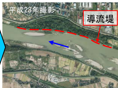
導流堤の施工により低水路が安定
