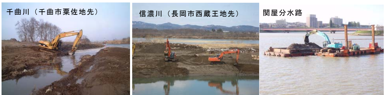
写真 53 河道掘削の実施例
