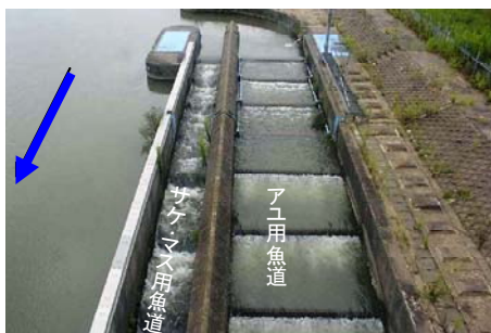
蒲原大堰に設置された魚道
