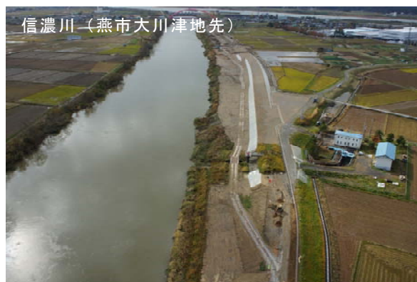
写真 52 堤防整備の実施例
