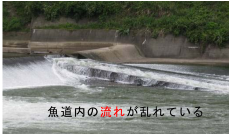
第二床固魚道
