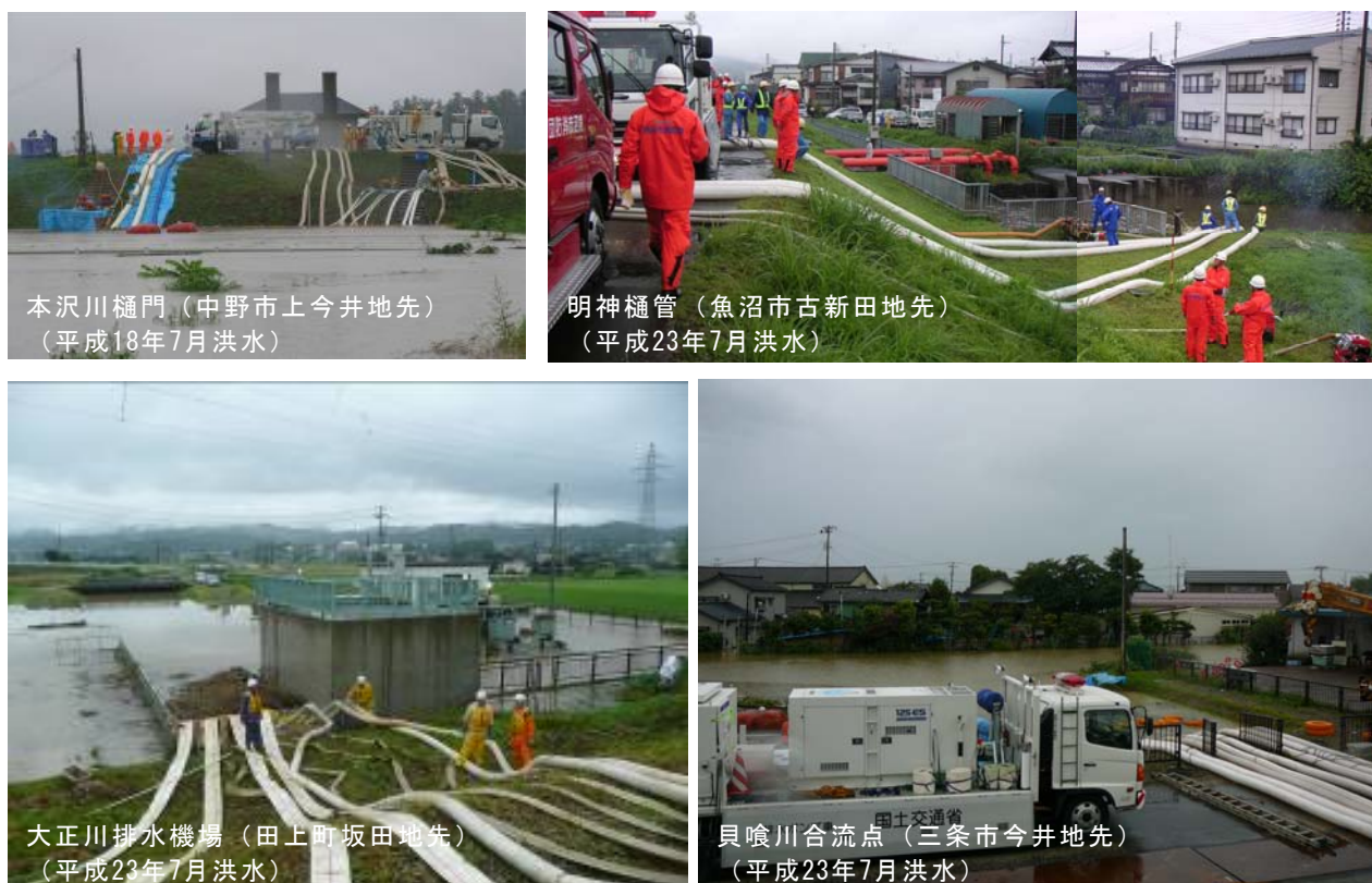
写真 9 内水被害発生と対策の実施状況
