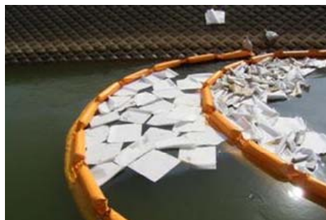
長岡市須川での油除去作業
