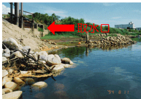
取水口からの取水不能(加茂市)
