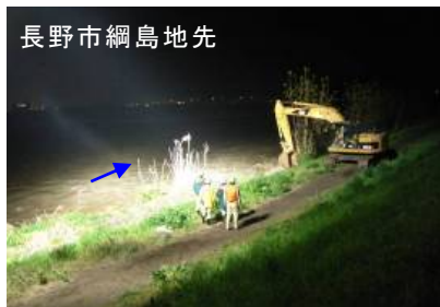
長野市綱島地先 平成23年5月洪水時の応急対応 写真13
