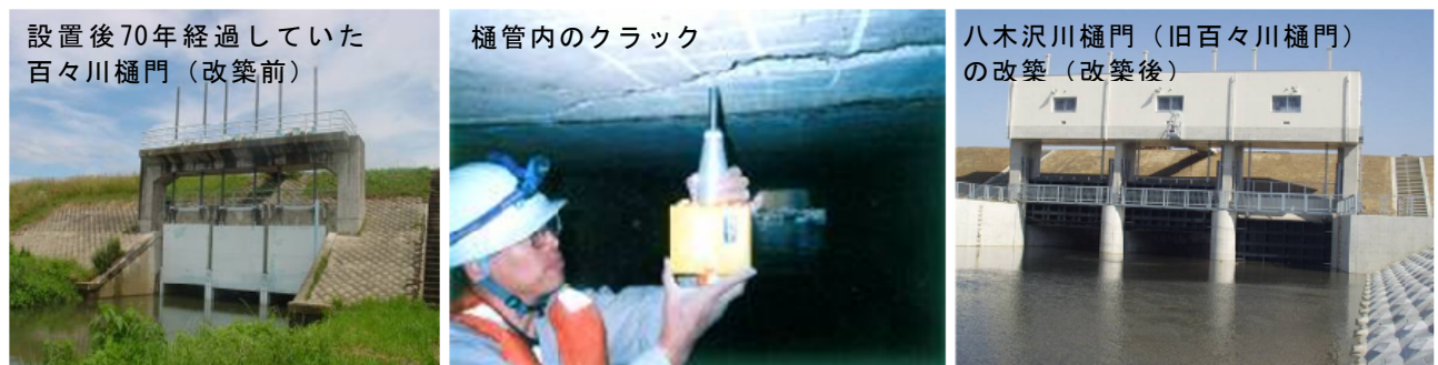
写真 19 八木沢川樋門(千曲川)の改築状況
