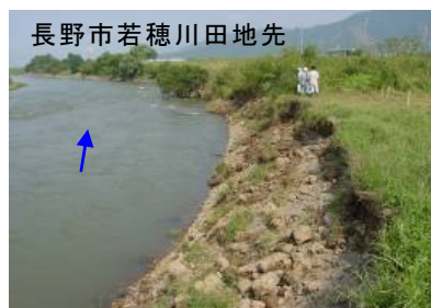
長野市若穂川田地先 平成16年10月洪水による河岸の侵食 河岸侵食の状況
