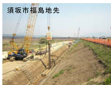
写真 12 漏水対策工事
