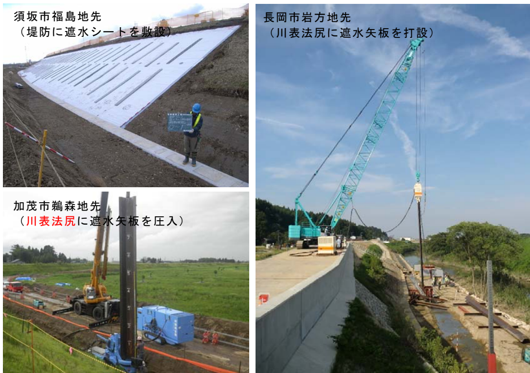
写真 54 浸透対策の実施例
