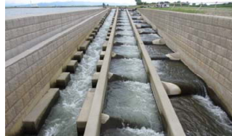
大河津可動堰魚道
