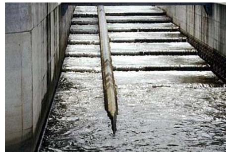
大島頭首工に設置された魚道
