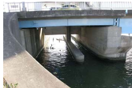
信濃川水門に設置された魚道
