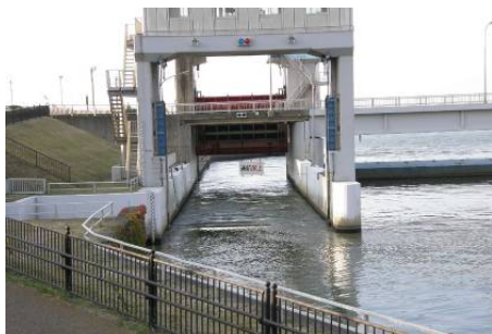
新潟大堰に設置された魚道
