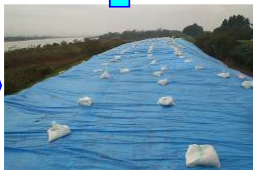
緊急復旧完了 (平成 16 年 10 月 25 日)
