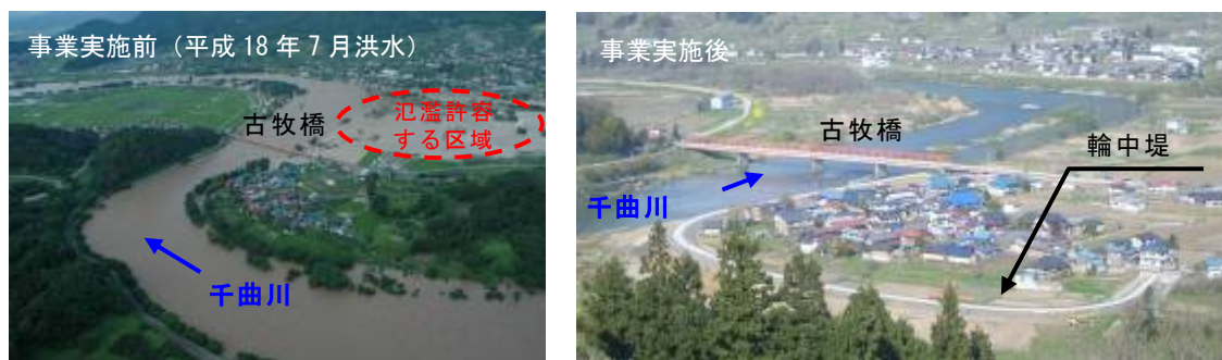
写真 4 土地利用一体型水防災事業で輪中堤を整備した中野市古牧地区（千曲川）
