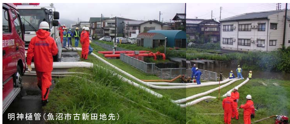
写真 7 内水対策の実施状況（平成 23 年 7 月洪水）
