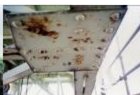
腐食している架台
