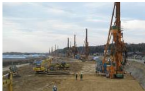
耐震対策の実施状況 (長岡市町軽井)
