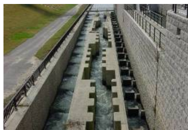
大河津洗堰の魚道(中流部) 平成 12 年改築
