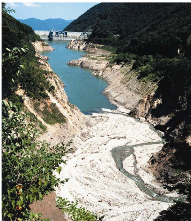
渇水時の大町ダム の状況
