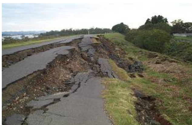
大規模崩壊(長岡市三俵野地先) (平成 16 年 10 月 24 日)
