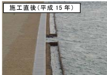
新潟市上所地区における矢板前面への植栽(マコモ)整備例
