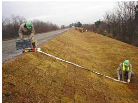
本復旧後の状況
