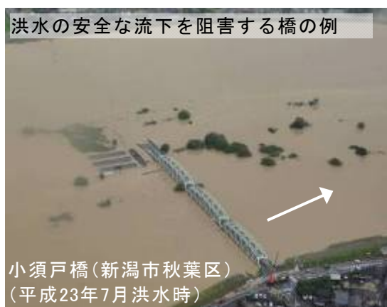
写真 5 改築が必要な横断工作物の例
