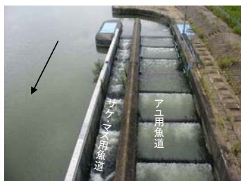
蒲原大堰の魚道(下流部)
