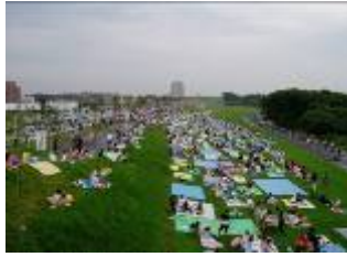
長岡市街地の緩傾斜 堤防：蓮潟地区
