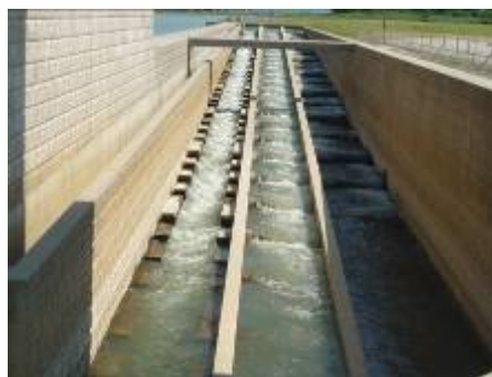
大河津可動堰の新たな左岸魚道
