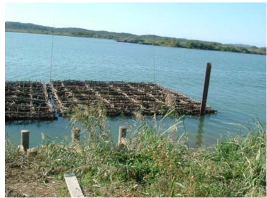
長岡市真代地先(粗朶沈床)
