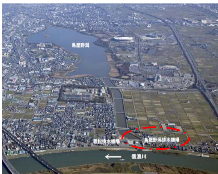
鳥屋野潟排水機場
