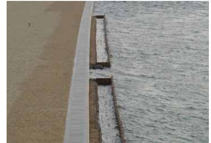
【施工直後(平成15年)】
