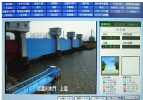
管内CCTV映像、水位情報の提供
