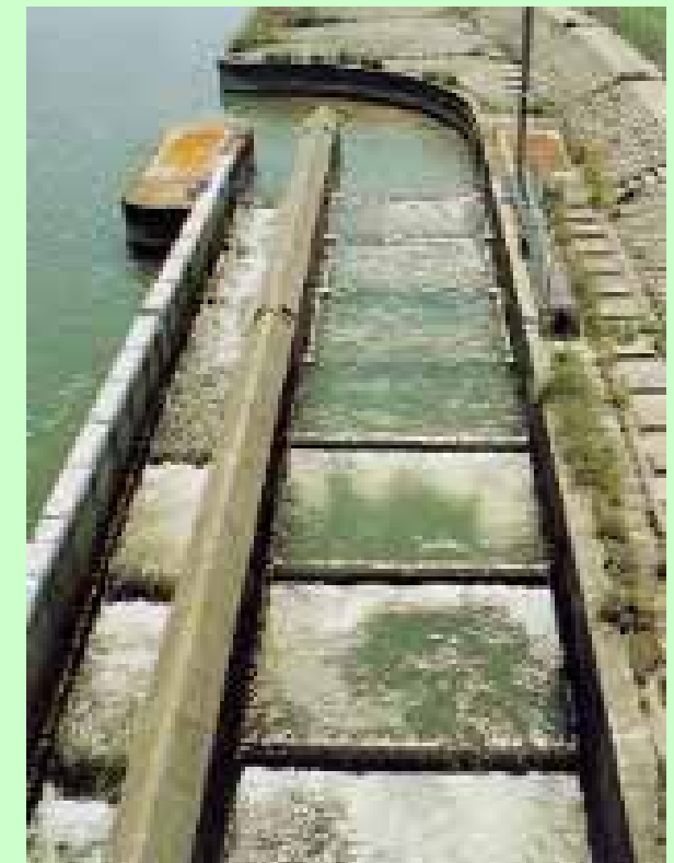
蒲原大堰魚道
