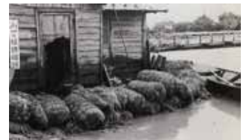
米俵による土嚢積み
