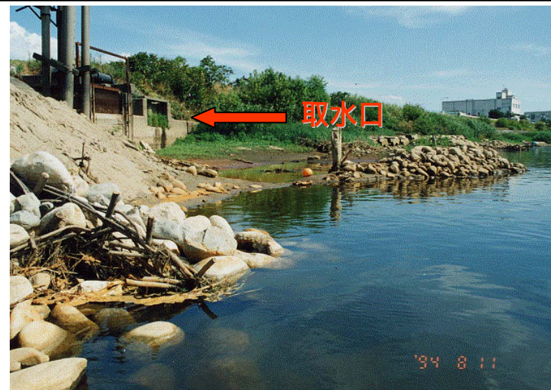
取水口からの取水不能（加茂市、平成6年渇水）
