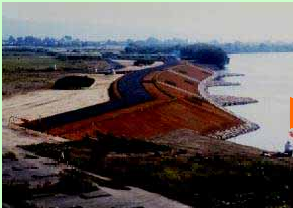
【施工中(平成4年)】
