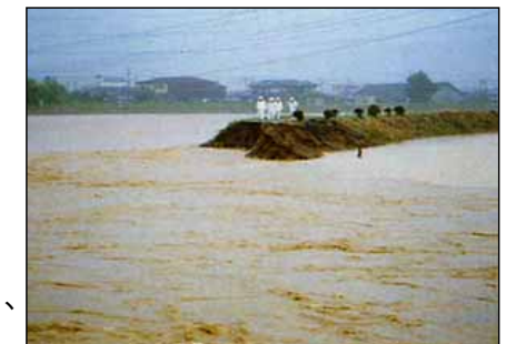
破堤した五十嵐川
