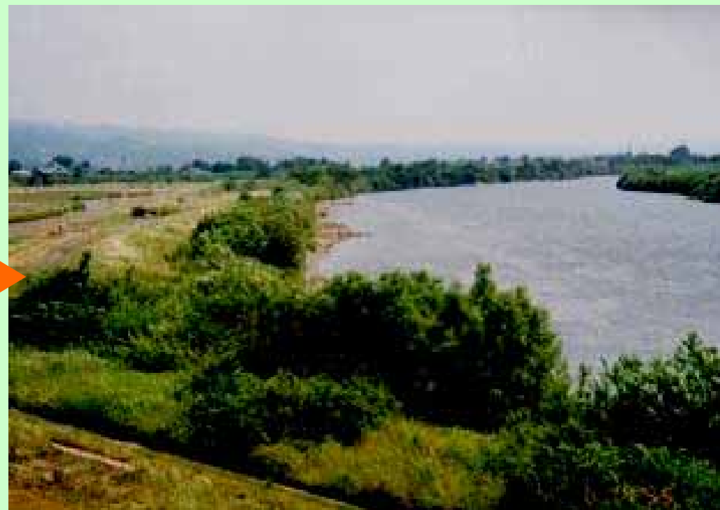
【施工後(平成11年)】
