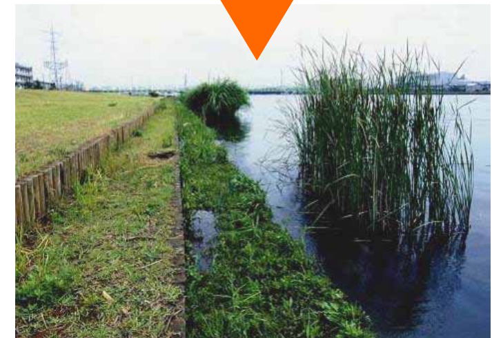
【施工後(平成16年)】
