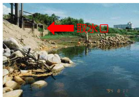
取水口からの取水不能（加茂市）
