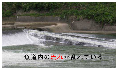
第二床固魚道
