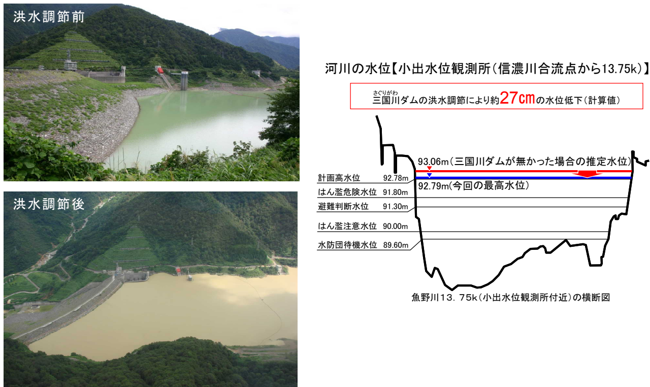
図 14 平成23年7月洪水時における三国川ダムの洪水調節の様子
