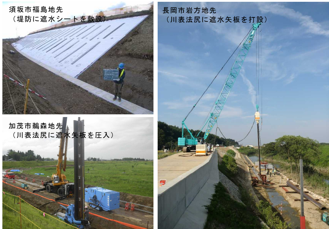
写真 54 浸透対策の実施例
