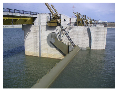
写真 68 大河津分水路における堰の高さを抑えて景観へ配慮した事例
