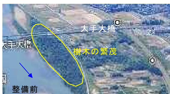
蓮濁地区の左岸寄州に樹木が繁茂
