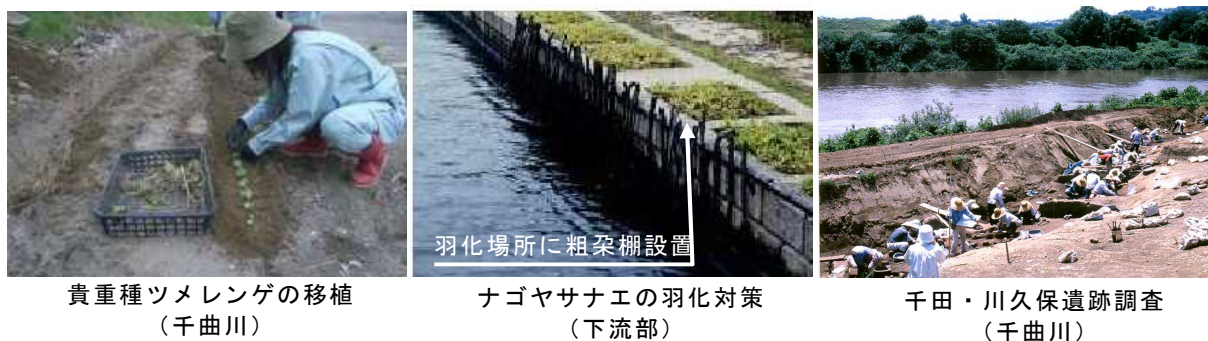
写真 66 工事による環境影響の軽減事例
