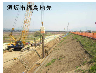
写真 12 漏水対策工事
