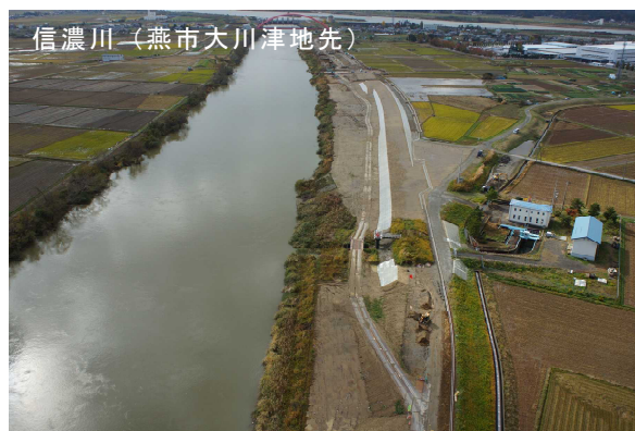
写真 52 堤防整備の実施例
