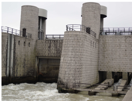
写真 68 大河津分水路における堰の高さを抑えて景観へ配慮した事例
