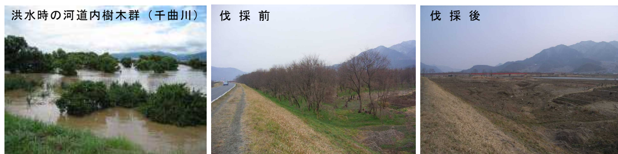
写真 50 樹木伐採の状況（上流部）
