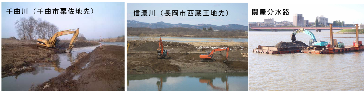
写真 53 河道掘削の実施例
