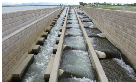
大河津可動堰魚道
