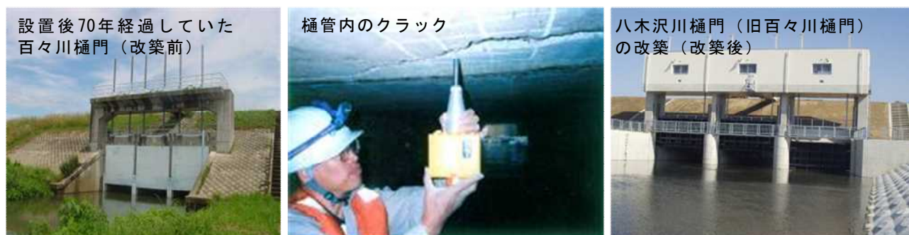
写真 19 八木沢川樋門(千曲川)の改築状況
