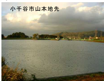
写真 22 山本調整池(JR 東日本、信濃川)
