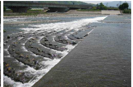
勘左衛門堰（犀川）の魚道
