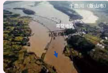
▲千曲川堤防の破堤(昭和58年9月)
