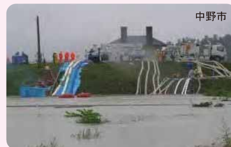
▲宅地側の支川での内水排除の実施状況
