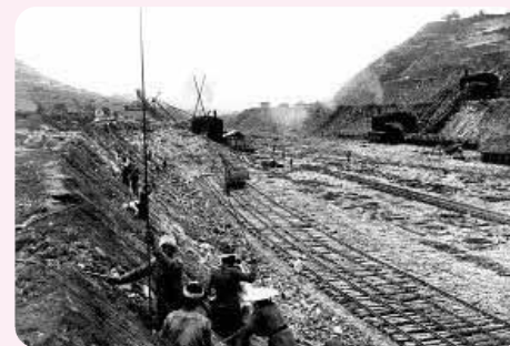
▲大河津分水路開削工事
