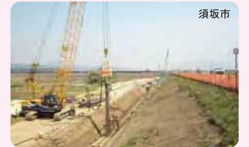
▲漏水対策の実施例
