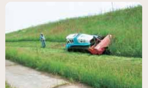
▲堤防除草の状況
