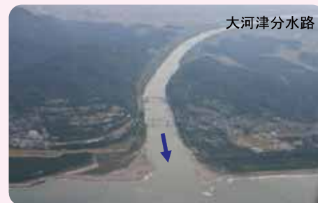
▲大河津分水路の状況
