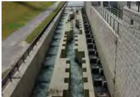
大河津洗堰魚道
