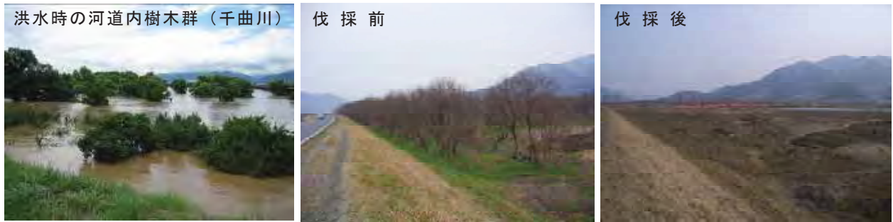
写真 50 樹木伐採の状況(上流部)
