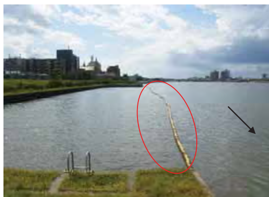
写真 85 不法係留船対策(下流部)
