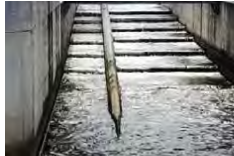
大島頭首工に設置された魚道
