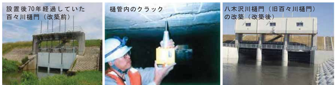
写真 19 八木沢川樋門(千曲川)の改築状況
