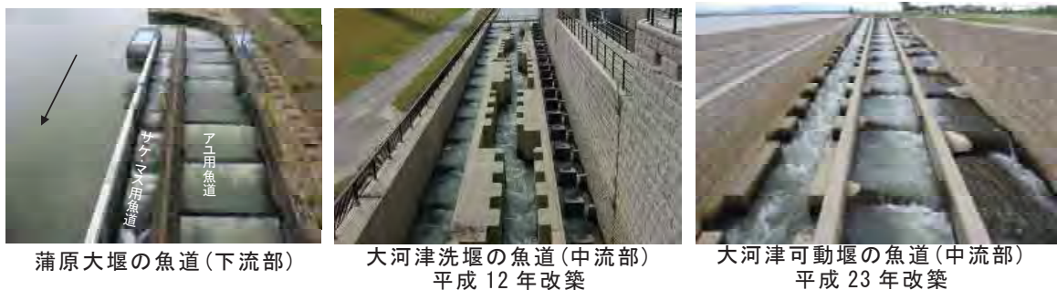
写真 68 魚道の設置事例
