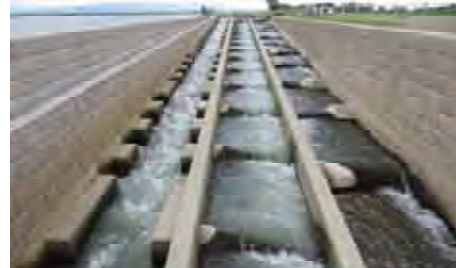
大河津可動堰魚道
