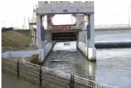
新潟大堰に設置された魚道
