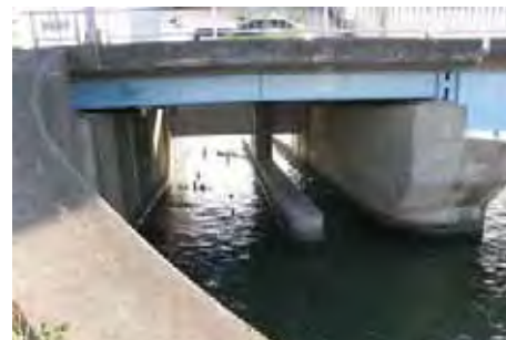
信濃川水門に設置された魚道
