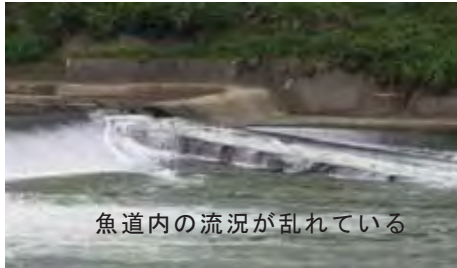
第二床固魚道
