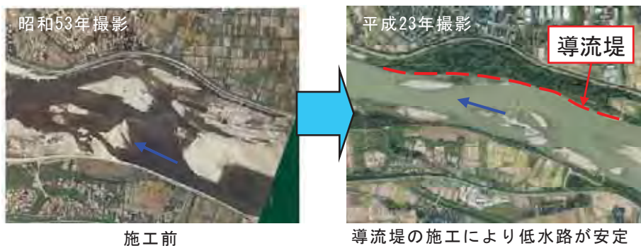
写真 14 長岡市水梨地区における水衝部対策工実施例
