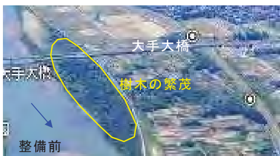
蓮濁地区の左岸寄州に樹木が繁茂
