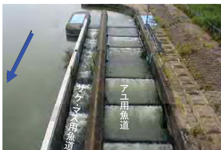
蒲原大堰に設置された魚道
