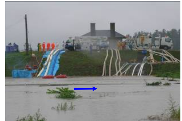
本沢川樋門(中野市上今井地先)
