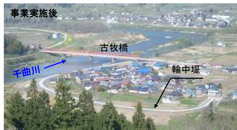
土地利用一体型水防災事業で輪中堤を整備した中野市古牧地区（千曲川）
