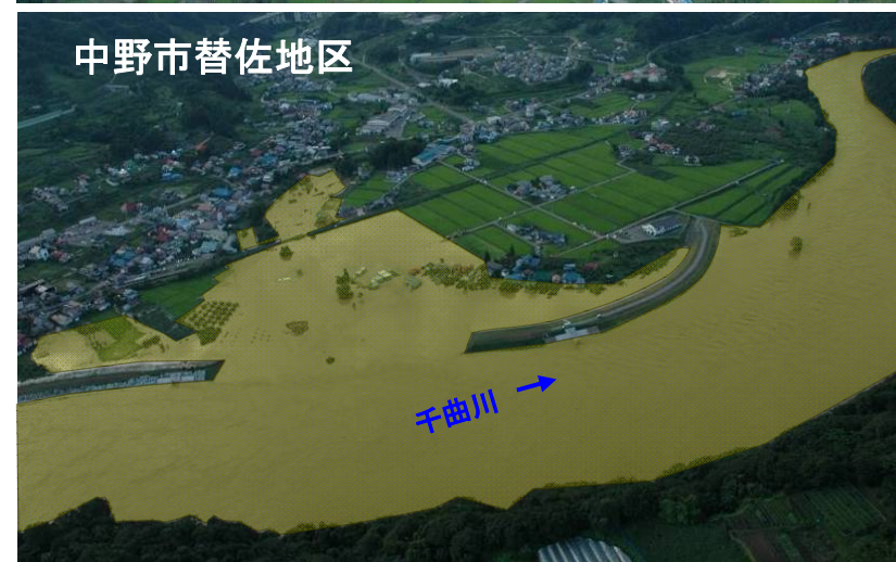
平成18年7月洪水における浸水被害の状況
