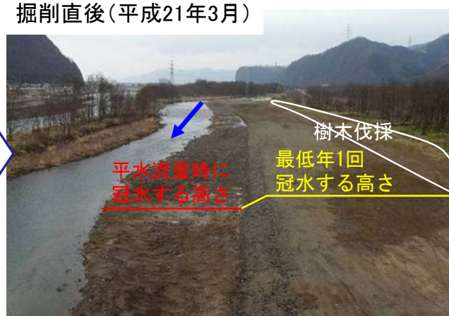
千曲川鼠地区での試験掘削
