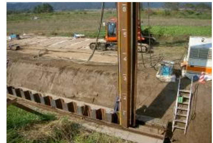
対策工事の事例
