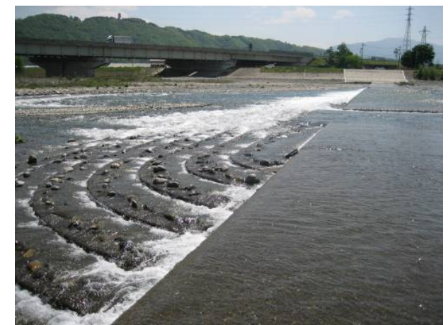
勘左衛門堰の改築された魚道(犀川) 17
