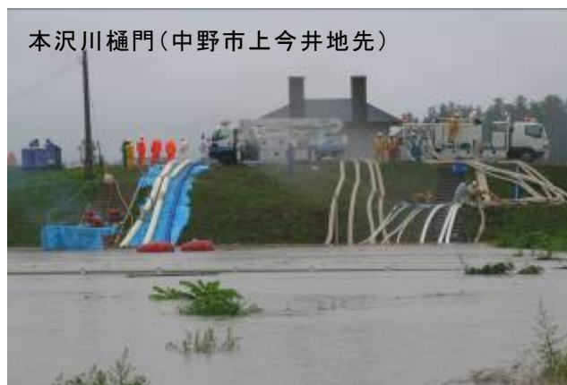
写真 6 内水対策の実施状況(平成 18 年 7 月洪水)
