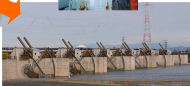
図 22 大河津可動堰の改築状況
