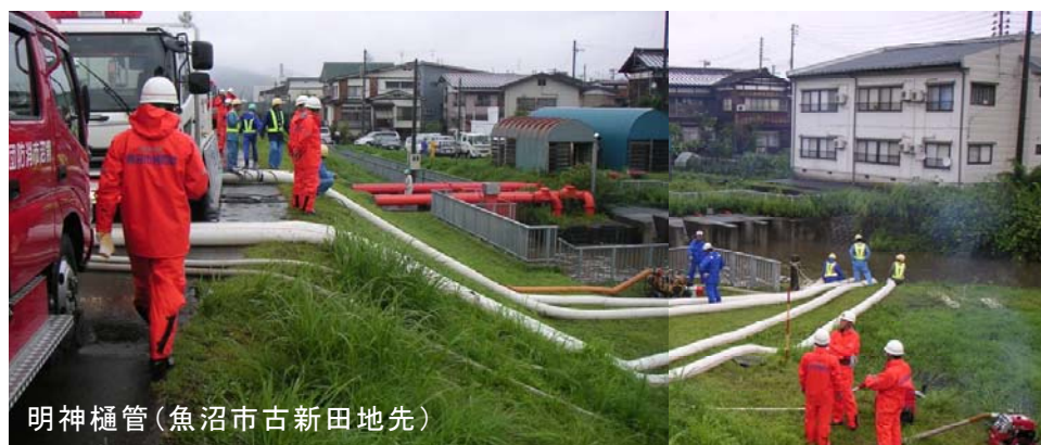
写真 7 内水対策の実施状況(平成 23 年 7 月洪水)
