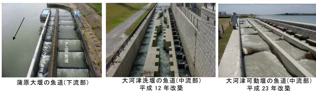
写真 32 魚道の設置事例
