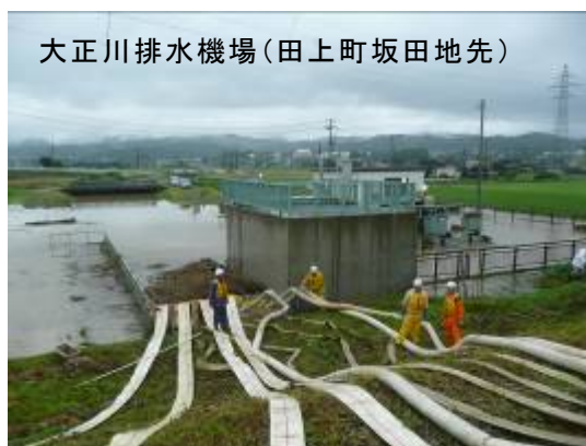
写真 8 内水対策の実施状況(平成 23 年 7 月洪水)
