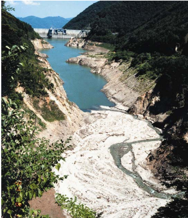
渇水時の大町ダムの状況
