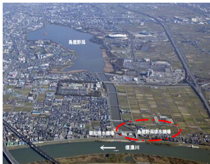
鳥屋野潟排水機場
