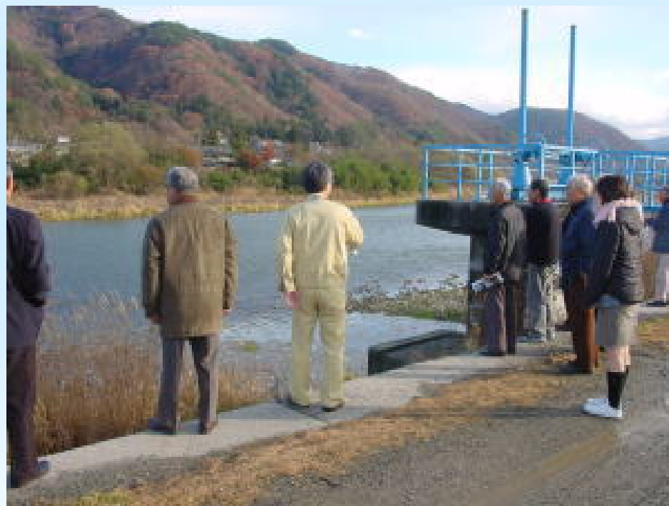
現地視察の状況
