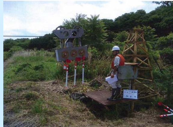
老朽化した浮子投下 施設
