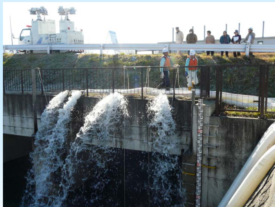
長野市篠ノ井 岡田樋門での実働訓練
