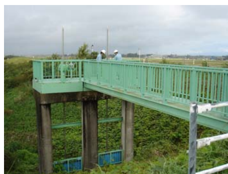
図 5-35 河川管理施設の点検
