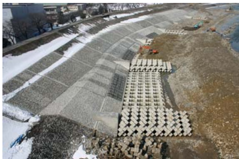
図 5-12 急流河川対策（根継ぎ護岸工）
