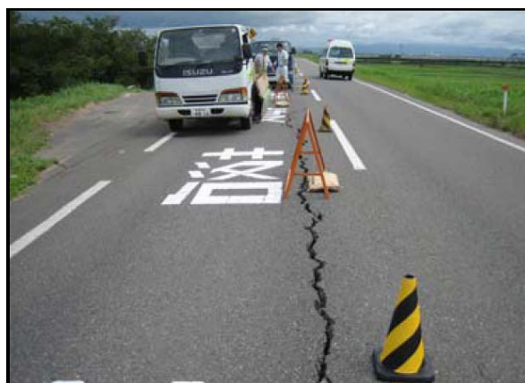
図 5-16 地震による堤防上面の亀裂
