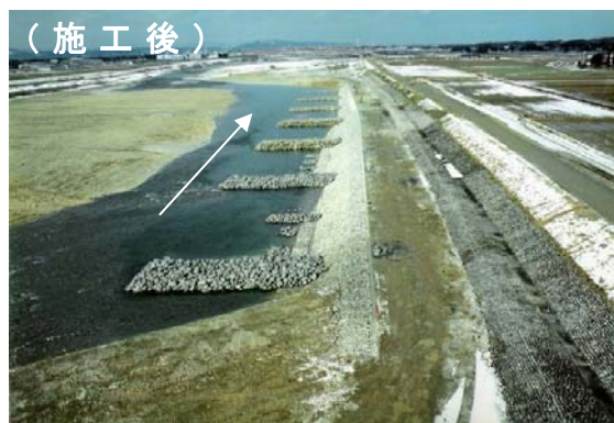
図 5-21 多自然川づくりの施工事例 ～ 自然石を用いた水制で新たに淵を創出する～ 左岸坂東地区右岸 (19.0k～19.3k)
