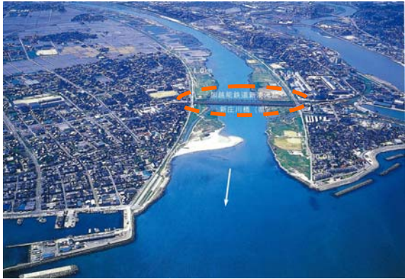
図 5-7 橋梁架替箇所の状況
