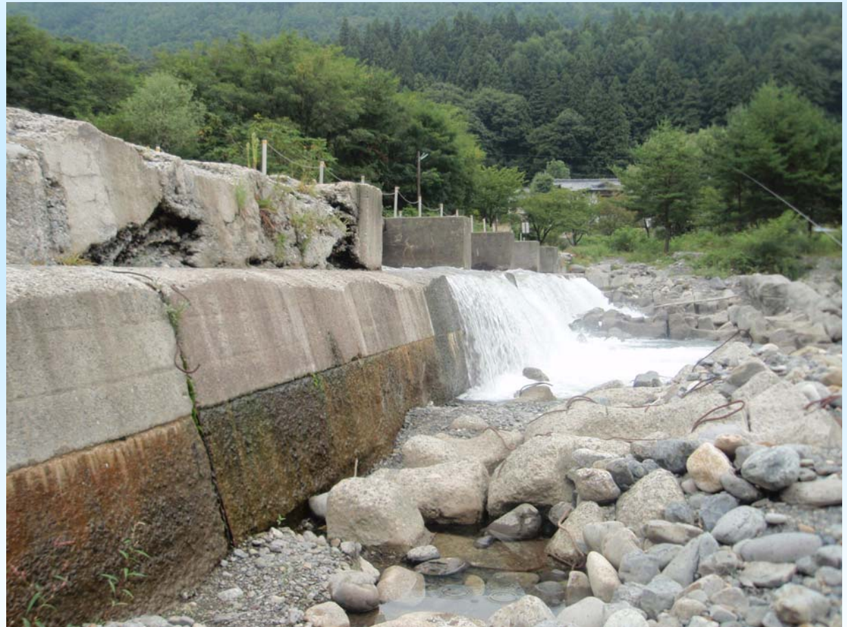
旧赤松頭首工(犀川)の状況
