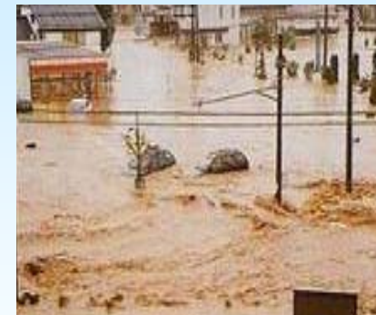
刈谷田川の破堤状況
