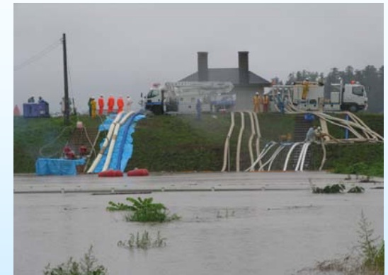
排水ポンプ車による内水対応
