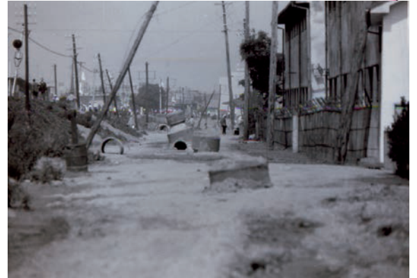
図-3.2 液状化で浮き上がったマンホール(新潟市中央区川岸町)
