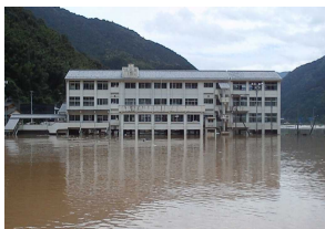
H26.8避難所2階の浸水 (徳島県)
