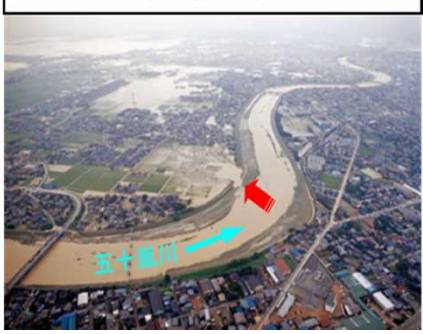
H16.7.13 五十嵐川破堤状況(三条市曲瀬)
