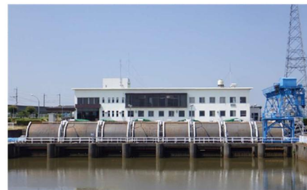
刈谷田右岸排水機場（三条市）
