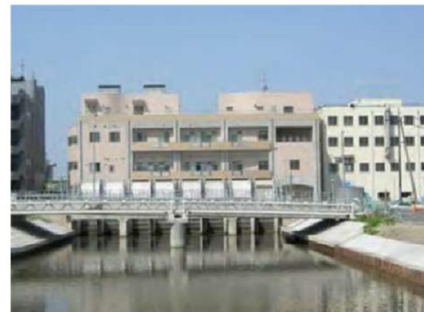
親松排水機場（新潟市）
