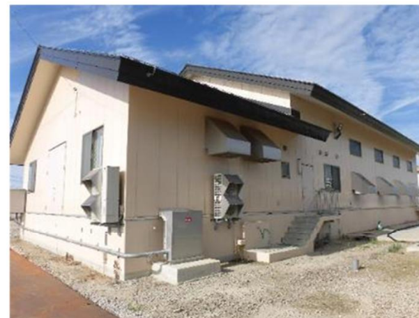
旧木山排水機場（新潟市）
