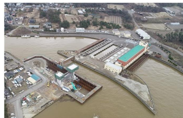
新川河口排水機場（新潟市）
