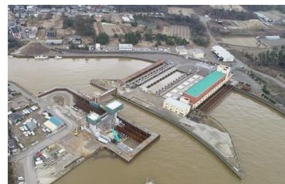
新川河口排水機場（新潟市）
