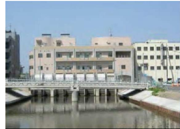
親松排水機場（新潟市）
