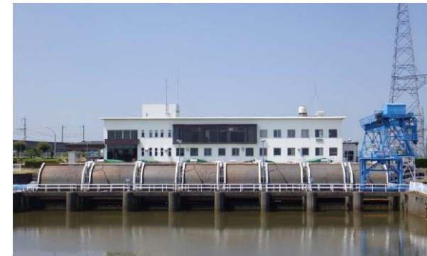
刈谷田右岸排水機場（三条市）
