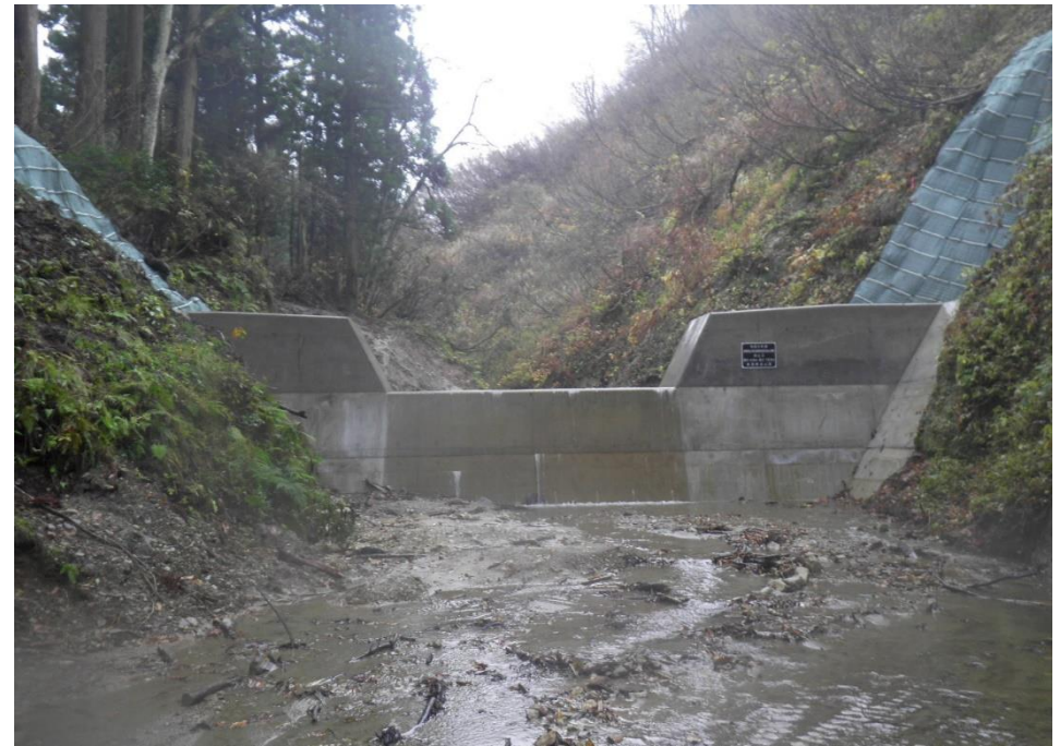
十日町市池沢の治山ダム整備状況(R6)
