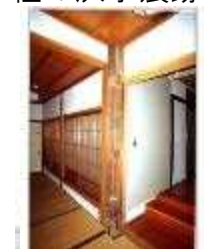
柱の洪水痕跡
