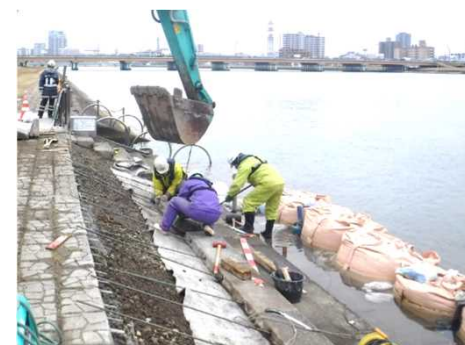
護岸補修作業
