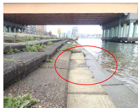
護岸ブロックの沈下
