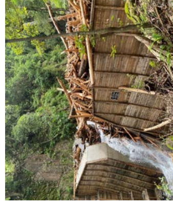
流木捕捉式治山ダムが流木を捕捉した事例【熊本県球磨村】
