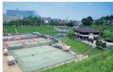
雨水貯留浸透施設の例(防災調整池)
