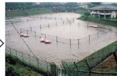
雨水貯留浸透施設の例(防災調整池)
