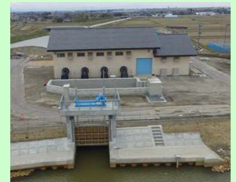
排水機場全景
