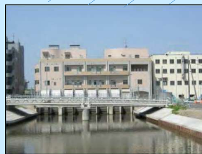
排水機場全景
